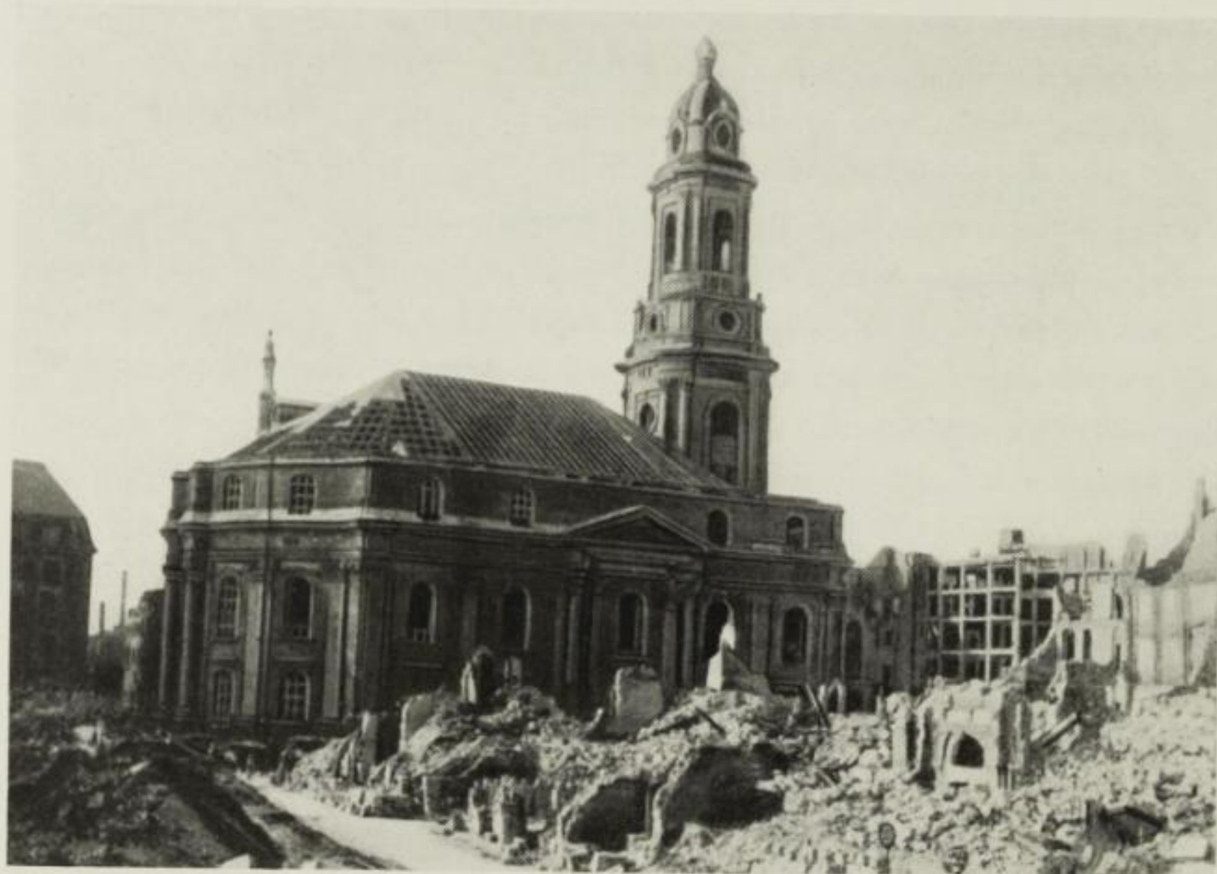
46. Die ausgebrannte Kreuzkirche bei Beginn der Dachreparatur
