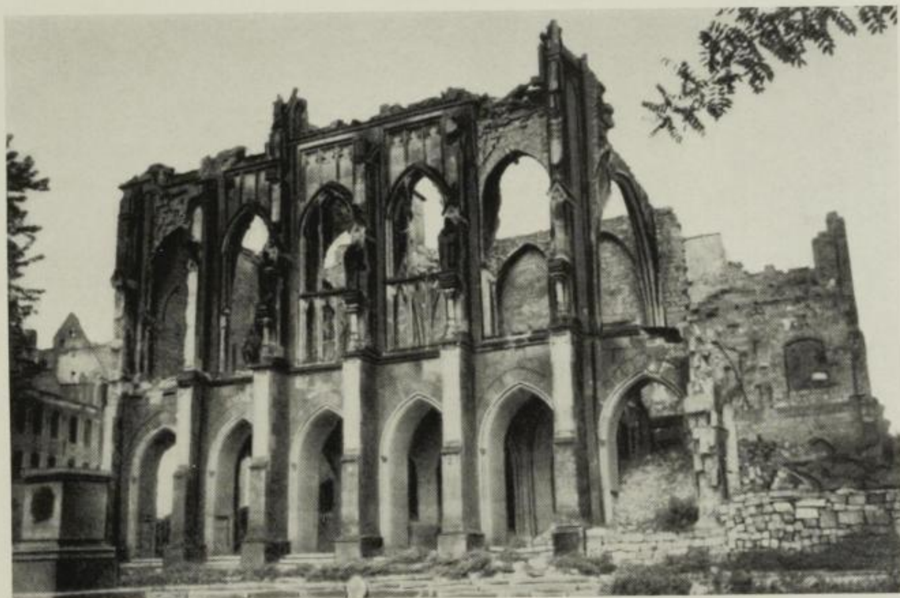
43. Fassade der ausgebrannten Kreuzschule
