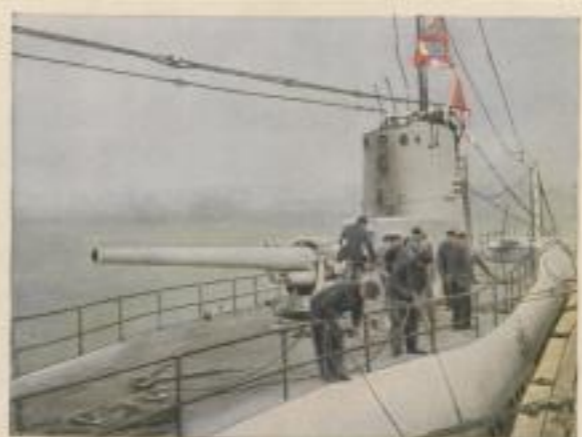
Amerikanisches U-Boot „V 4 Argonaut“ mit Deckgeschütz. Kaliber 15,2 cm. Schußweite 17,3 km. 4 Torpedoausstöße
