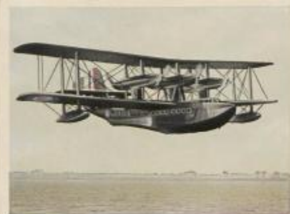
Englisches größtes Patrouillenschiffboot zur Fernaufklärung „Short R 6/28“. Motorleistung 6 x 930 P.S. Höchstgeschwindigkeit 240 km pro Std. Flugweite 3000 km. Bombenlast 800 kg. Besatzung 10 Mann
