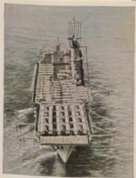
Amerikanisches Flugzeugmutterschiff „Saratoga“. Besatzung 1962 Mann, Wasserverdrängung 33 000 t, Fassungsvermögen 60 Flugzeuge
