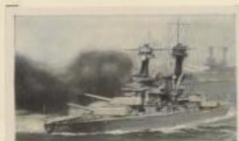
Amerikanisches Linienschiff „West Virginia“ im Feuer. Besatzung 1407 Mann. Wasserverdrängung 33100 t. Bestückung 8 × 40,6, 12 × 12,7 cm Kanonen und 8 × 12,7 cm Flak
