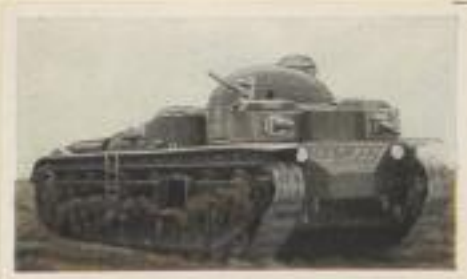
Größter englischer Vickers-Tank, Motorstärke 380 PS. Das Gesamtgewicht beträgt 32 t, die Höchstgeschwindigkeit 25 km pro Stunde. Besatzung 10 Mann.
