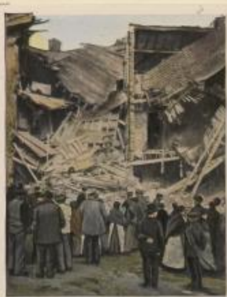
Zerstörtes Wohnhaus durch Einschlag einer 50 kg-Minenbombe
