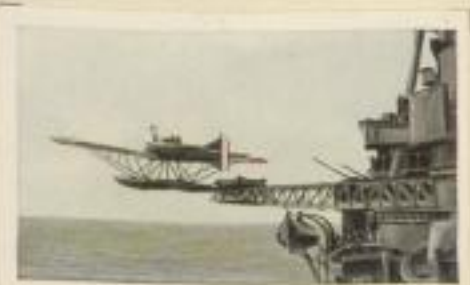
Start des Katapultflugzeuges von dem französischen geschützten Kreuzer „Colbert“ zum Entdeckungsluft
