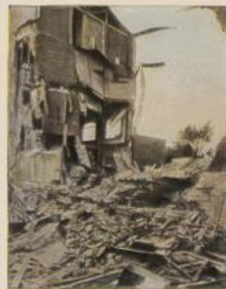
Zerstörtes vierstöckiges Wohnhaus durch eine englische 50 kg-Minenbombe, mit Verzögerung geworfen. Hierbei erlitt das Nachbarhaus dieselbe Zerstörung bis auf die Grundmauern
