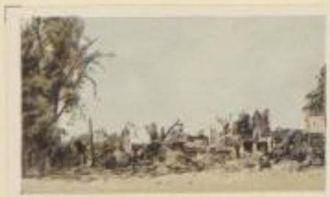
Zerstörter Häuserkomplex durch eine 1000 kg Minenbombe französischen Ursprungs
