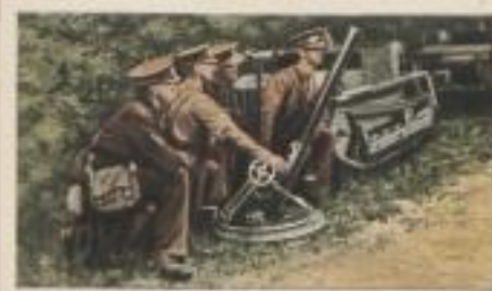
Engländer motorisierter Minenwerfer zur Bekämpfung von Tanks und besonders besetzter Grabenstellungen
