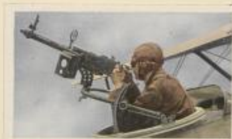
Amerikanisches Beobachter-Maschinengewehr auf einem drehbaren Maschinengewehrschwert, das zur Verteidigung gegen Angriffe nach allen Richtungen hin geschwenkt werden kann
