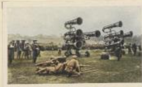
Japanischer Suchapparat zur Feststellung der Flugrichtung und Entfernung feindlicher Flugzeuge. Ein wichtiges Instrument für den Flugmeldebetrieb
