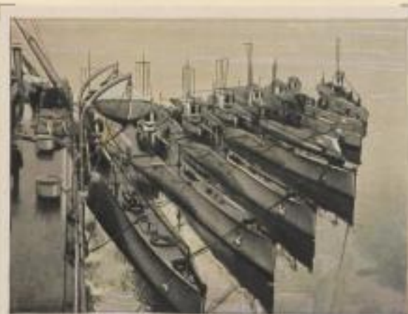
Amerikanisches U-Boot-Geschwader, bereit zum Auslaufen. Besatzung je 42 Mann. Wasserverdrängung 1110 t. Bestückung 1 × 10,2 cm Kanone und 4 Torpedoausstoßrohre
