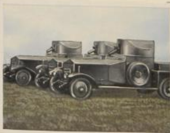
Engl. Holt-Katze-Straßenpanzer „M. 20“. Besatzung 4 Mann. Bewaffnung 1 Vickers-MG. im Drehturm. Höchstgeschwindigkeit 80 km p. Std.
