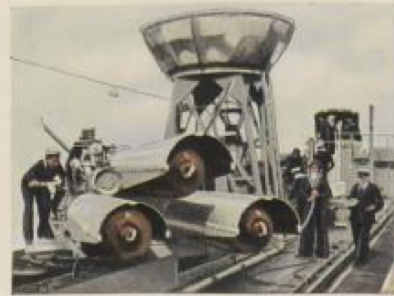
Torpedoausstoßrohr, geladen, auf dem englischen Zerstörer „Walter“. Die Torpedos werden mittels Preßluft abgeschossen und unter Wasser vorwärts bewegt
