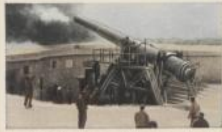
Amerikanisches schweres Küstengeschütz im Feuer. Kaliber 35,5 cm. Geschützgewicht etwa 300000 kg. Schußweite 42 km
