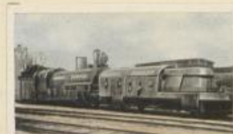
Polnischer Panzerwagen. Bewaffnung 2 Feldkanonen, 2 leichte Feldhaubitzen, 16 MG.
