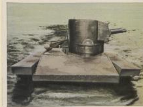
Englischer 3-Mann-Tank im Wasser schwimmend, Bewaffnung 1 Vickers-MG, Munition 2500 Schuß
