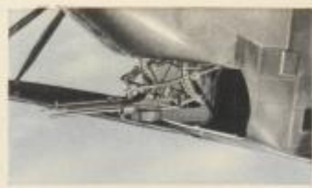
Maschinengewehrstand des französischen Mehrzweckflugzeuges „Breguet 412“. Die Zwillingsmaschinen-gewehre können, gekuppelt bedient, 2000 Schuß pro Minute feuern.
