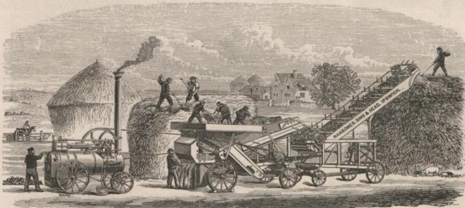
ein grosses Sieb mit der Maschine in Verbindung gebracht, welchem die Aufgabe zufällt, das gequetschte und zerschnittene Stroh zu reinigen. Der erste Holzschnitt auf der zweiten Seite zeigt eine solche Dampfdreschmaschine in Thätigkeit. Will man
