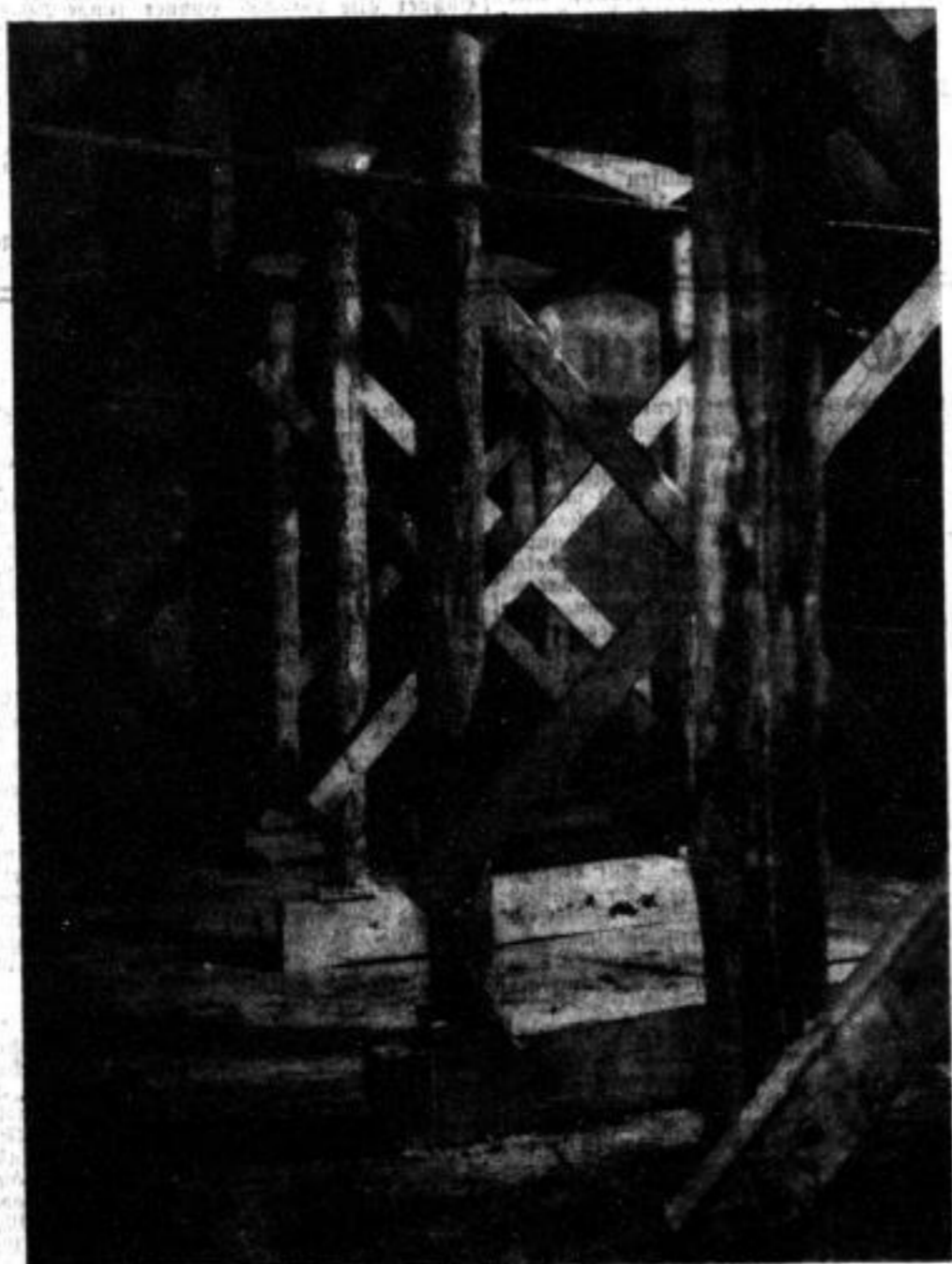
Abfliegen in der Gaschleuse
