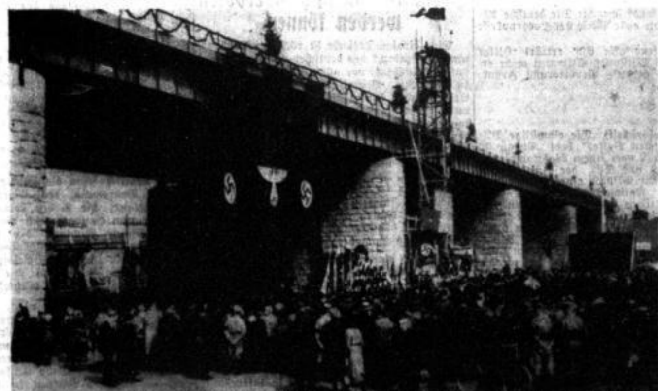
Vom Bau der Reichsautobahn
