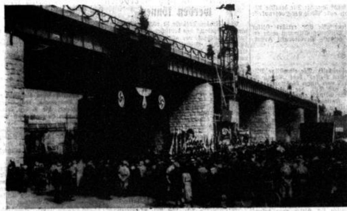
Vom Bau der Reichsautobahn
