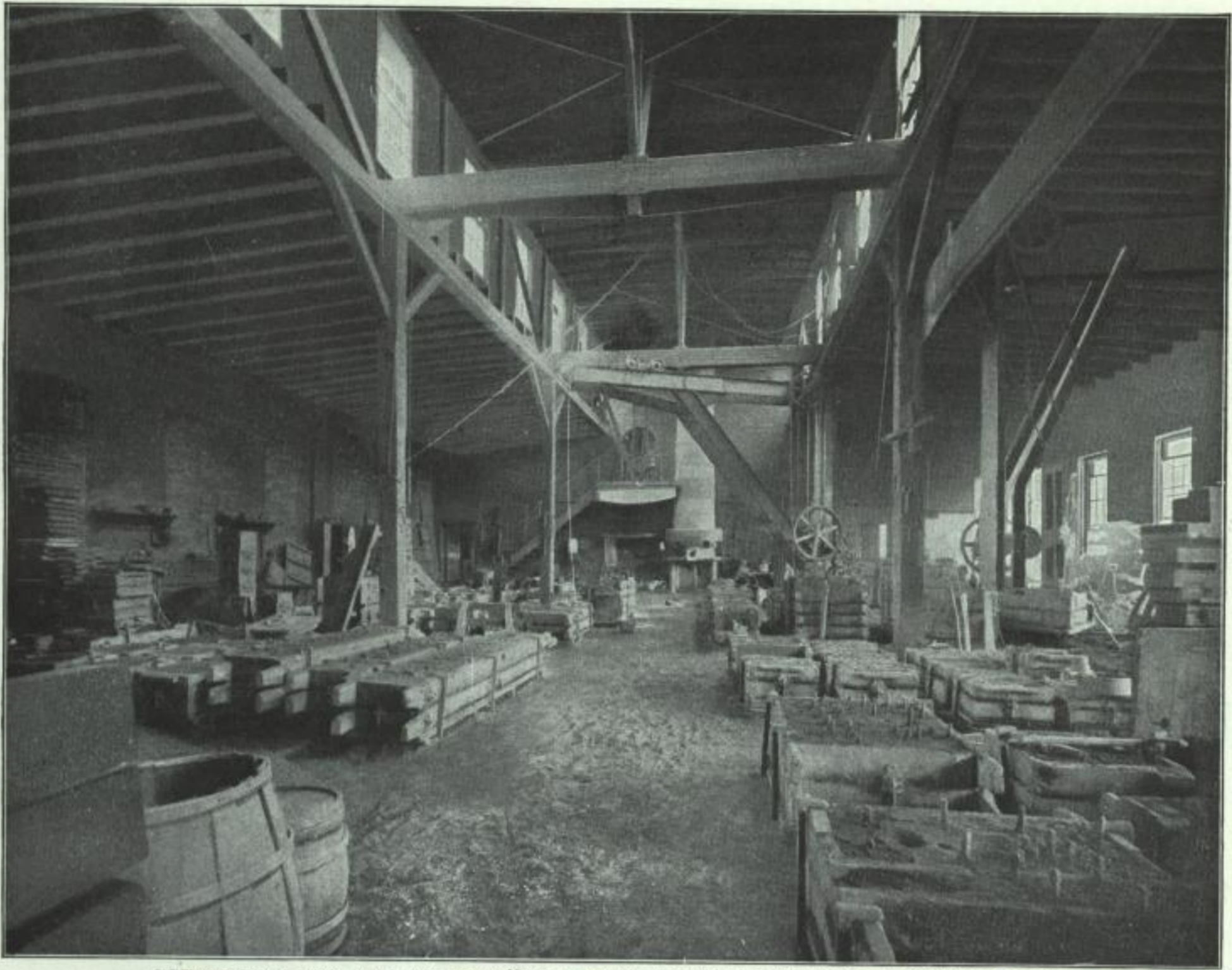
GIESSEREI—WO DIE GUSSSTÜCKE DER MASCHINEN GEMACHT WERDEN.
