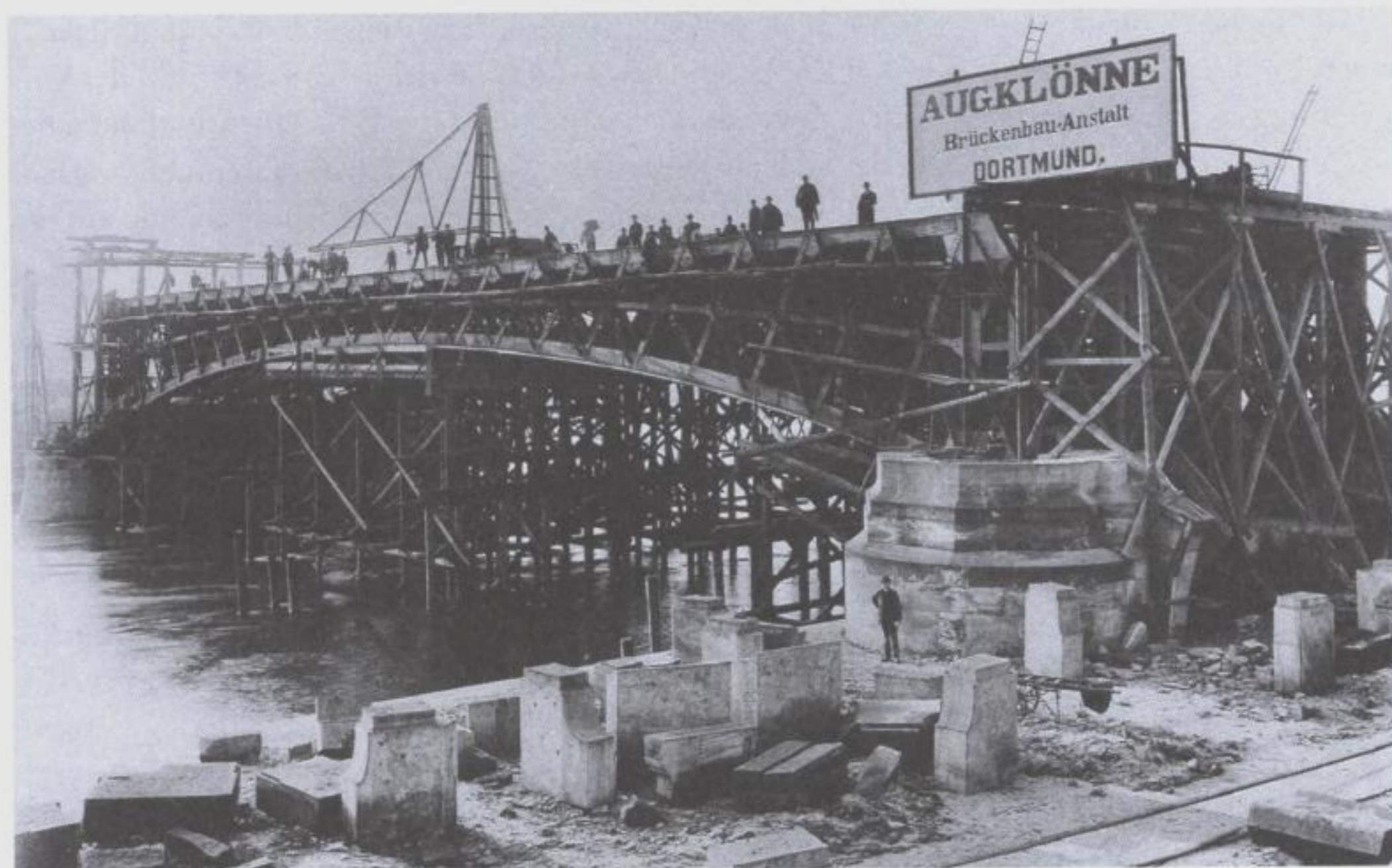
Bau der Marienbrücke II, 1900
