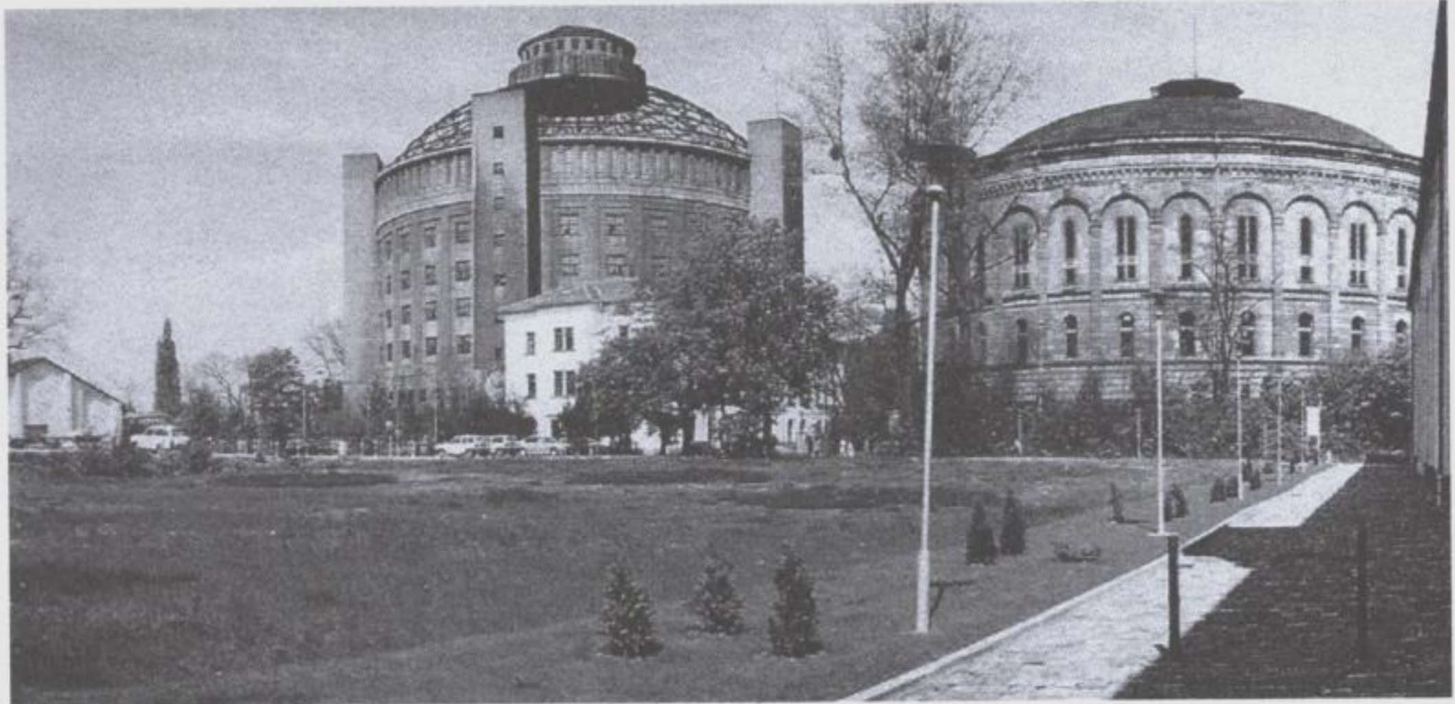
Gasbehälter der Gasanstalt Reick, Foto Peltz, 1996
