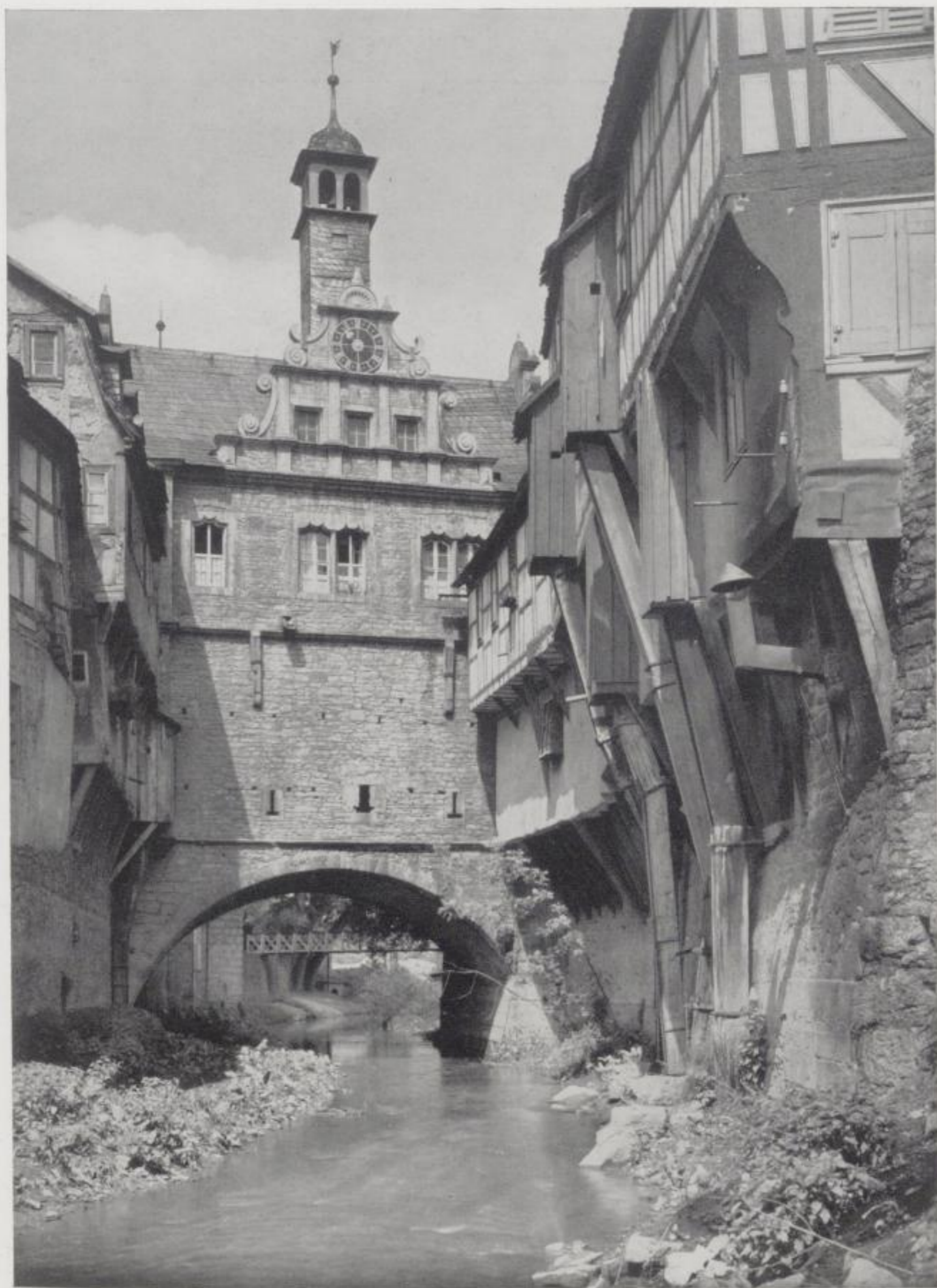
Marktbreit. Das Maintor über dem Breitbach (um 1600). Dem Baumeister war die dreifache Aufgabe gestellt, Rathausanbau, Brücke und Tor in einem Bau unterzubringen. Unsere Abbildung zeigt sein Seitenbild. Über dem Brückensbogen liegt die seitlich gedeckte Durchfahrt, die vorne und hinten mit Toren gesperrt werden konnte, über der Durchfahrt die Fenster, der Giebel und das Glockentürmchen des Toroberbaues, der sich harmonisch an den älteren Rathausbau anschließt. Malerisch verbinden sich die Fachwerkhäuser auf den beiden Ufern des Breitbachs mit dem Rathausbau. Ihre „Priväter“ und Küchen hatten ihre direkte Ableitung in den Bach, dessen schnellfließendes Wasser für eine rasche Abfuhr sorgte.
