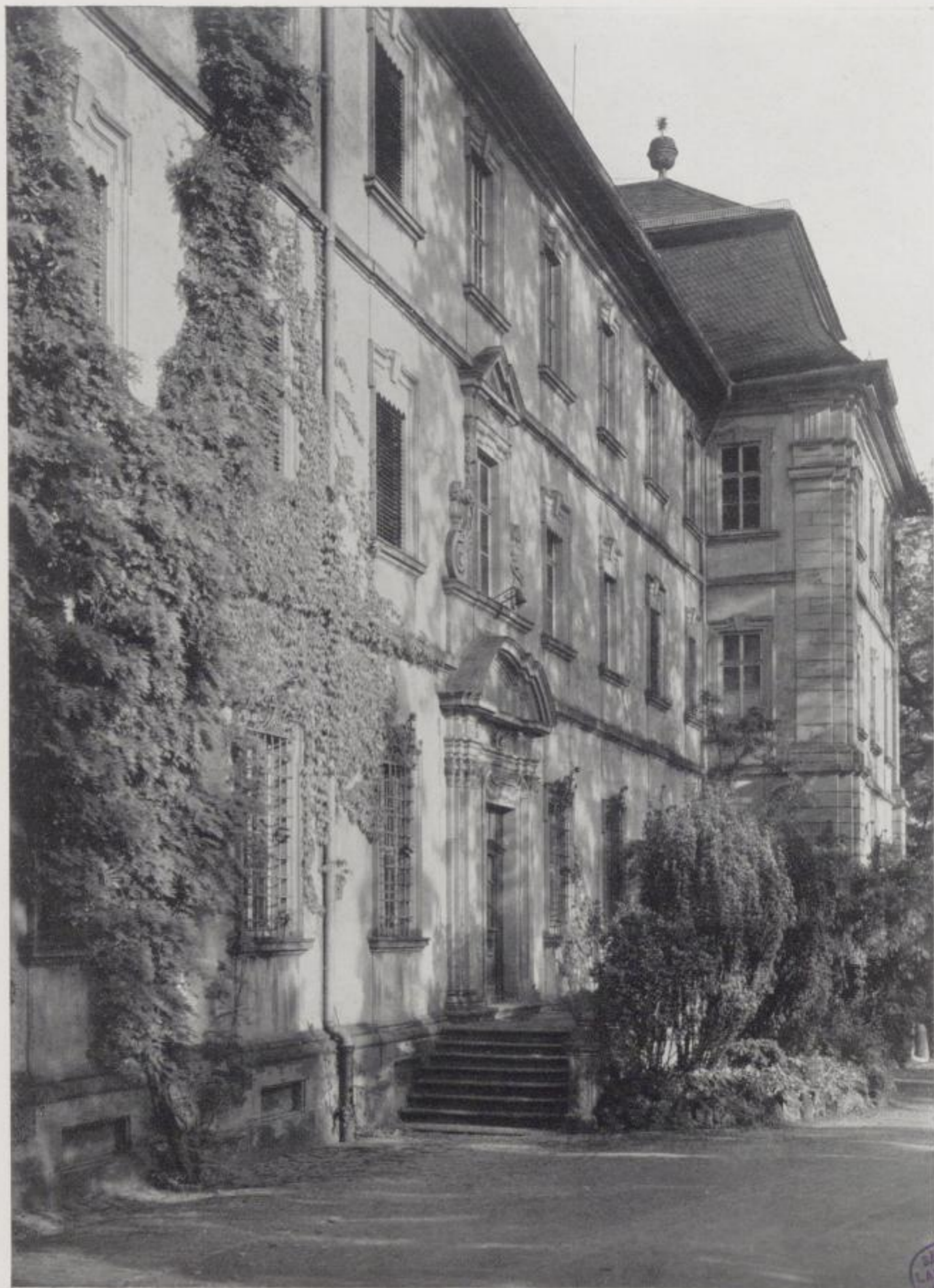
Obertheres. Ehemaliges Benediktinerkloster, um 1045 gegründet. Die Kirche (1809 abgebrochen, um Steine für Viehställe zu gewinnen) und die Konventsgebäude wurden durch Abt Gregor II. Zuchß nach den Plänen des Würzburger Baumeisters Joseph Greising 1716–46 neu aufgeführt. Heute im Besitz der Herren von Swaine.
