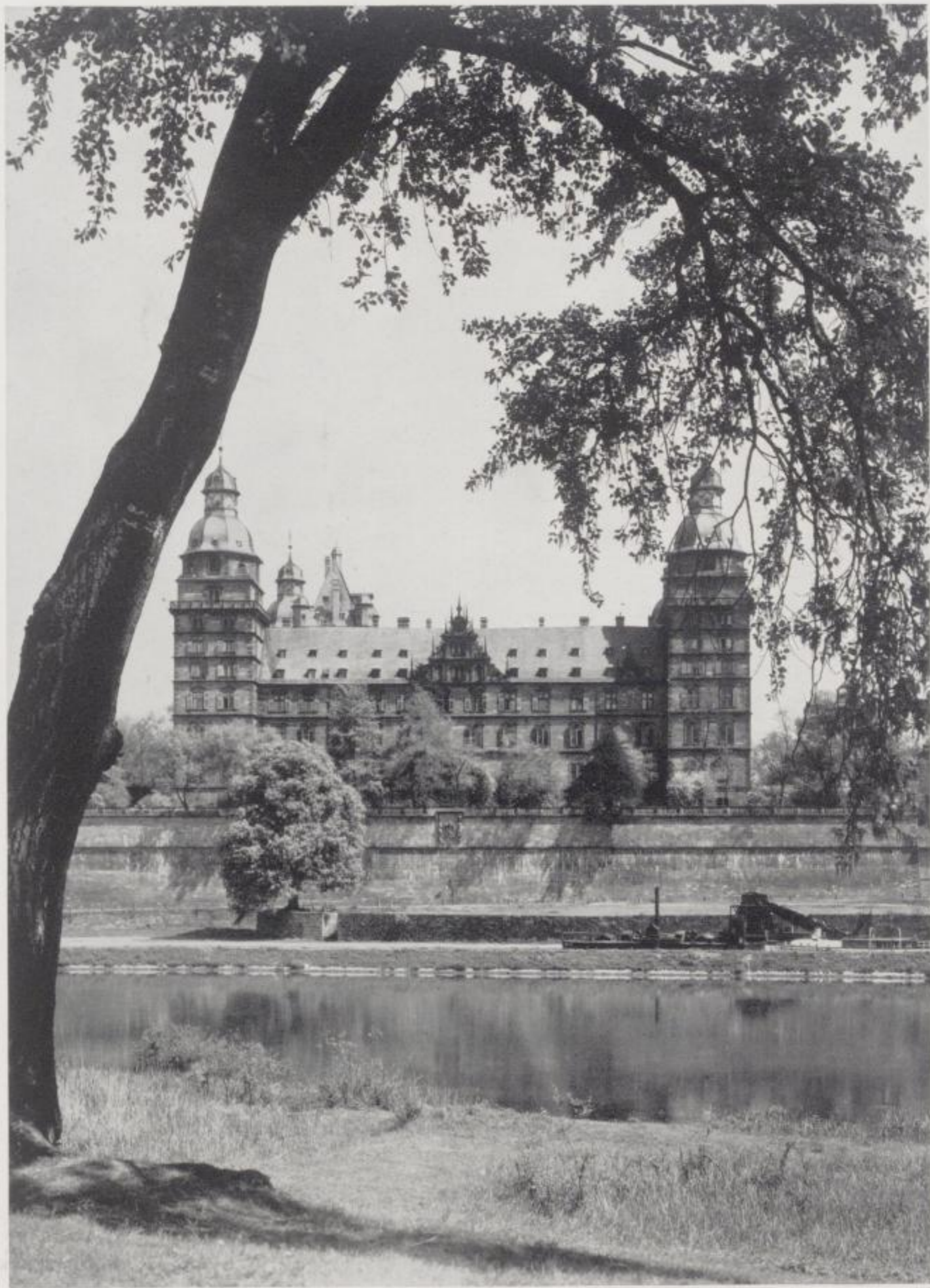
Aschaffenburg. Schloß, 1605—14 erbaut durch den Erzbischof Schweikard von Cronberg an Stelle der früheren Johannsburg über der hohen Uferterrasse mit dem Wappen des Erbauers, datiert 1607. Baumeister Georg Rüdinger von Straßburg. Das Schloß war bis 1803 die Sommerresidenz der Erzbischöfe von Mainz, bis 1813 des Fürstprimas und Großherzogs von Frankfurt Carl von Dalberg, dann der bayrischen Könige. Seit 1919 Museum.
