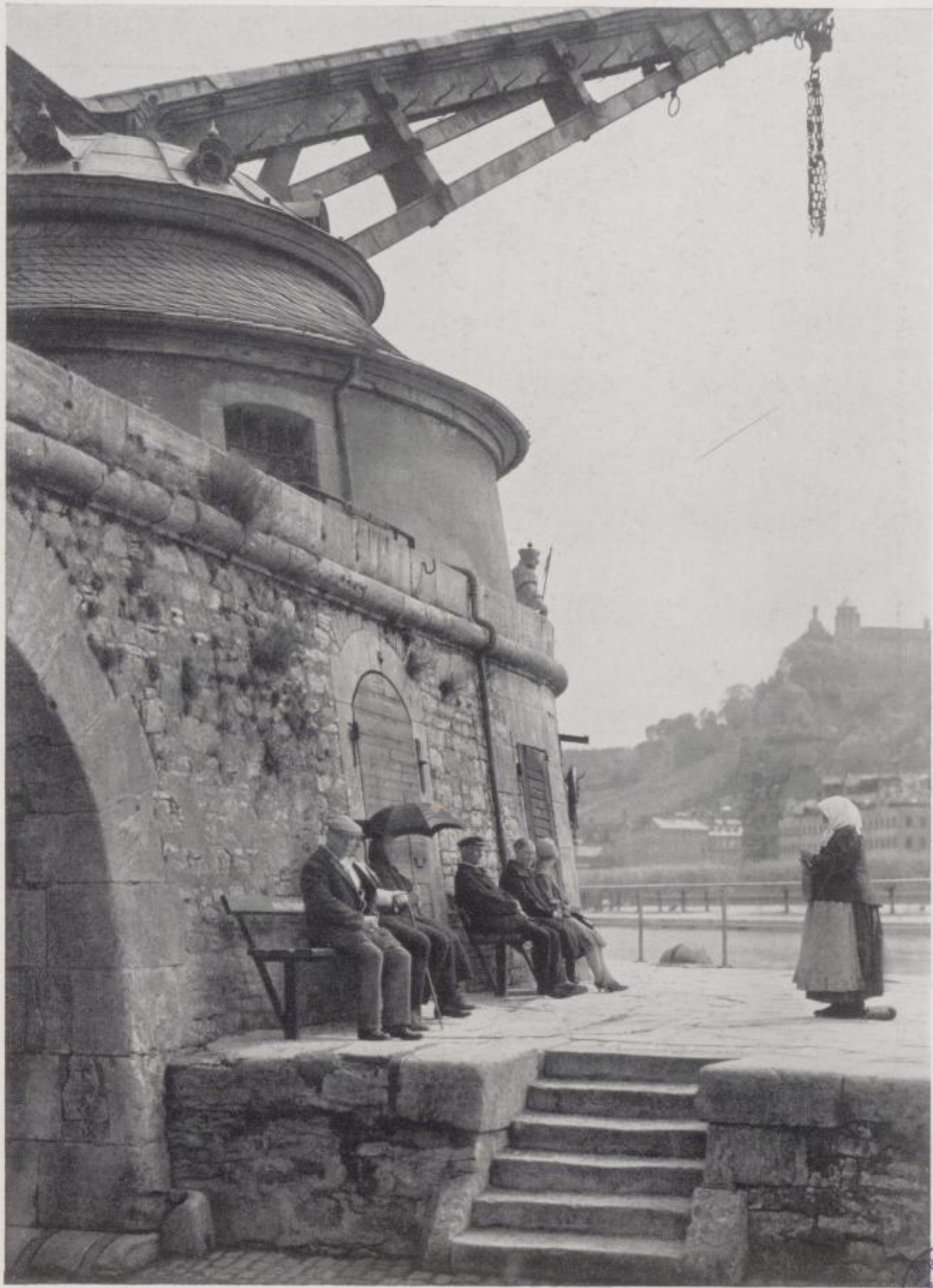
Würzburg. Der große Kran mit doppeltem Ausleger, an Stelle eines älteren 1773 von Fürstbischof Adam Friedrich von Seinsheim (1755–79) nach den Plänen des Ignaz Neumann, des Sohnes Balthasar Neumanns, errichtet. Einst vielbewundertes technisches Meisterwerk.
