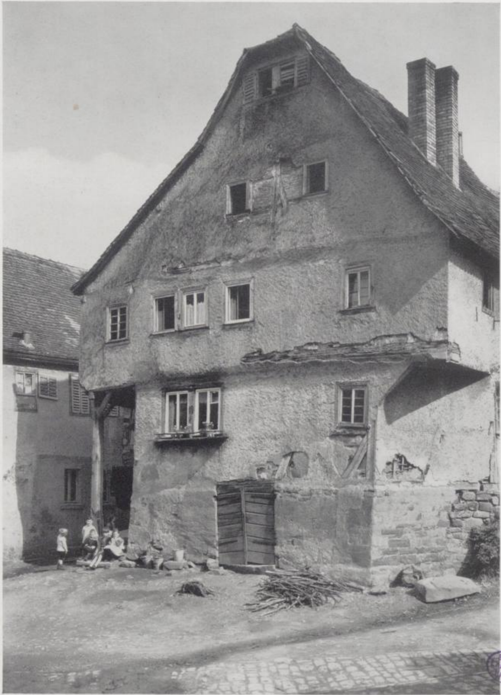
Laudenbach. Bauernhaus mittelalterlicher Bauart. Das Alter dieses interessanten Bauwerkes ist schwer festzustellen, da direkte Daten fehlen. Seine Bauart — Fachwerk unter neuem Verputz auf Bruchsteinsockel — weist noch in das 15.—16. Jahrhundert zurück, in denen ähnliche Abschrägungen des Erdgeschosses auf Bildern der fränkischen Schule dargestellt sind.
