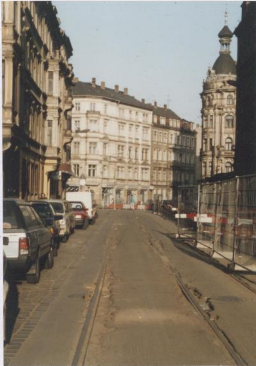
Bild 8: Hier entsteht ein eigener Bahnkörper für die Straßenbahnlinien 6, 13 und 26
