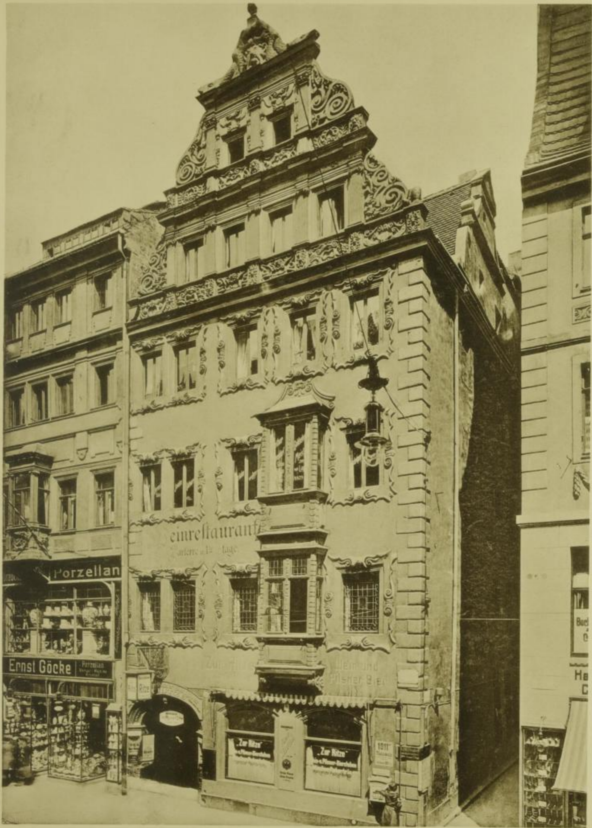
Das Schönrock'sche Haus, Wilsdruffer Straße 14.
