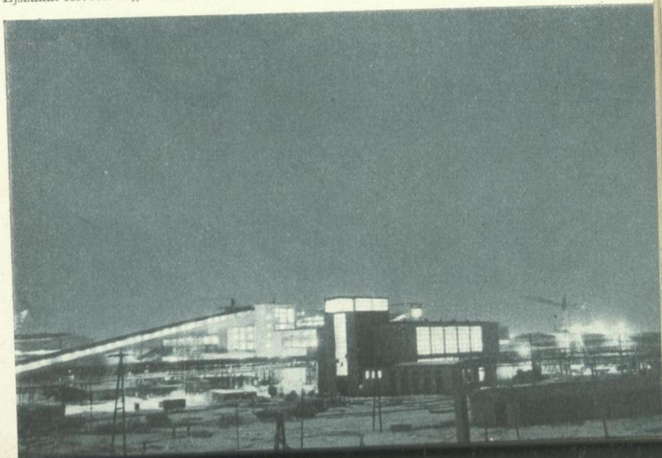
Éjszakai felvétel a „Schwarze Pumpe” barnaszén-kombinát építéséről
