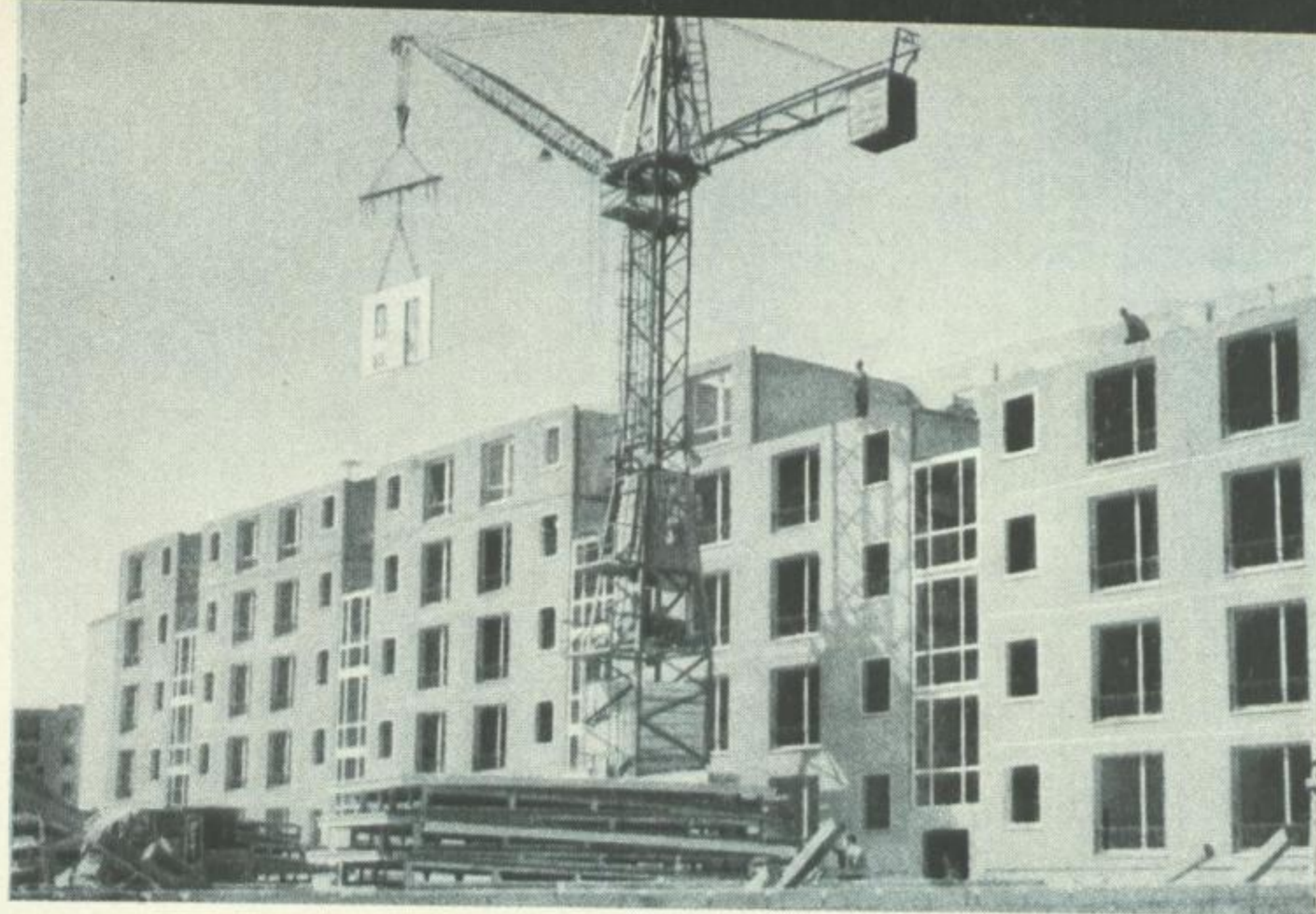
Lakásépítés előregyártott beton elemekkel
