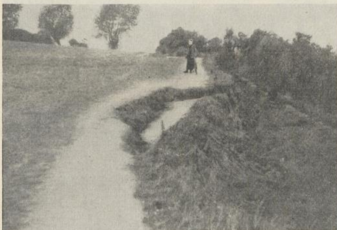
Bild 76. Schollensenkung der Oberflächenwasser am Kliff
