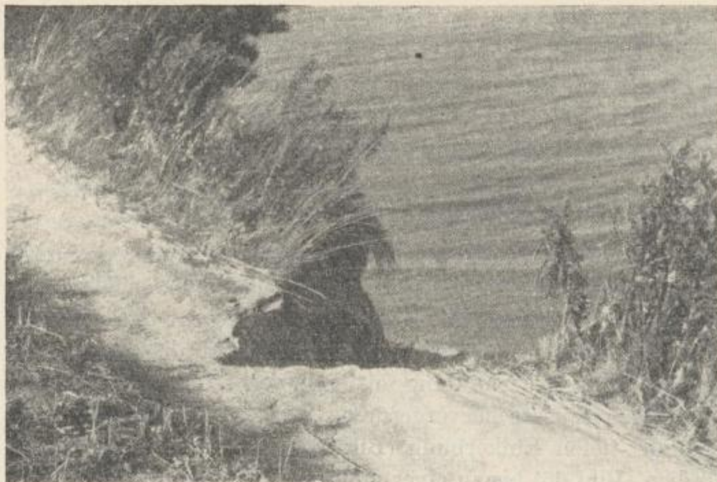
Bild 64. Erosions- einkerbung am Kliff
