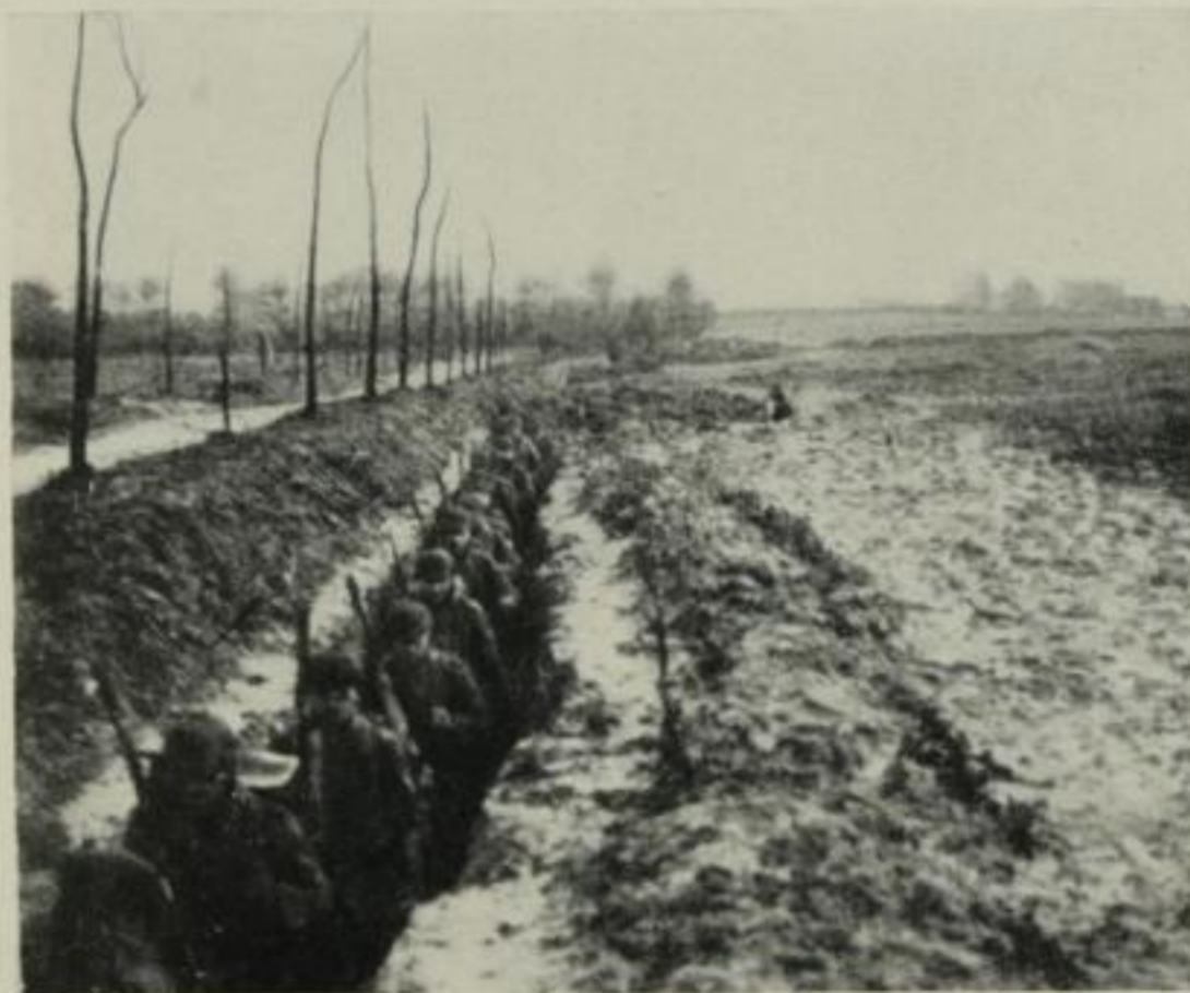
Laufgraben von Kiesgrube nach Straßenkreuz
