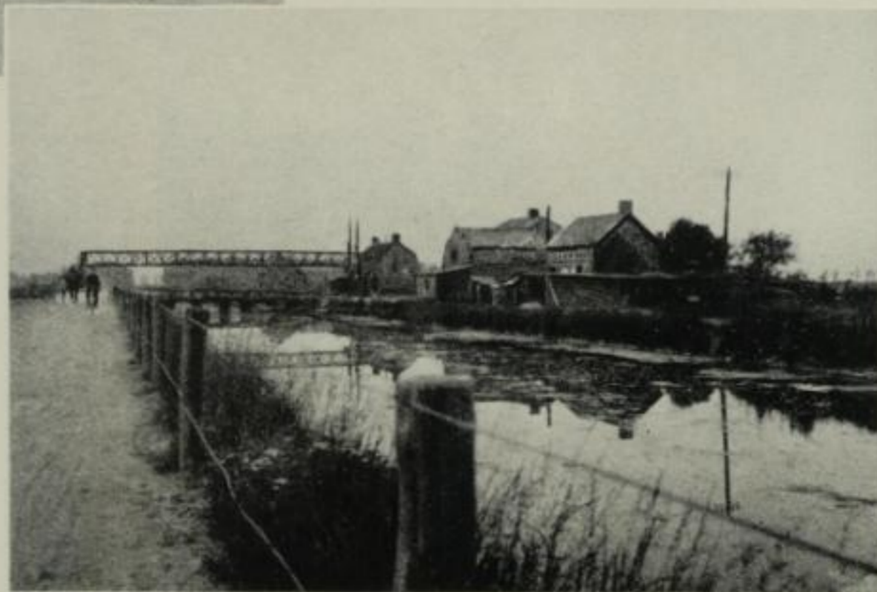
Kanalbrücke Le Marais
