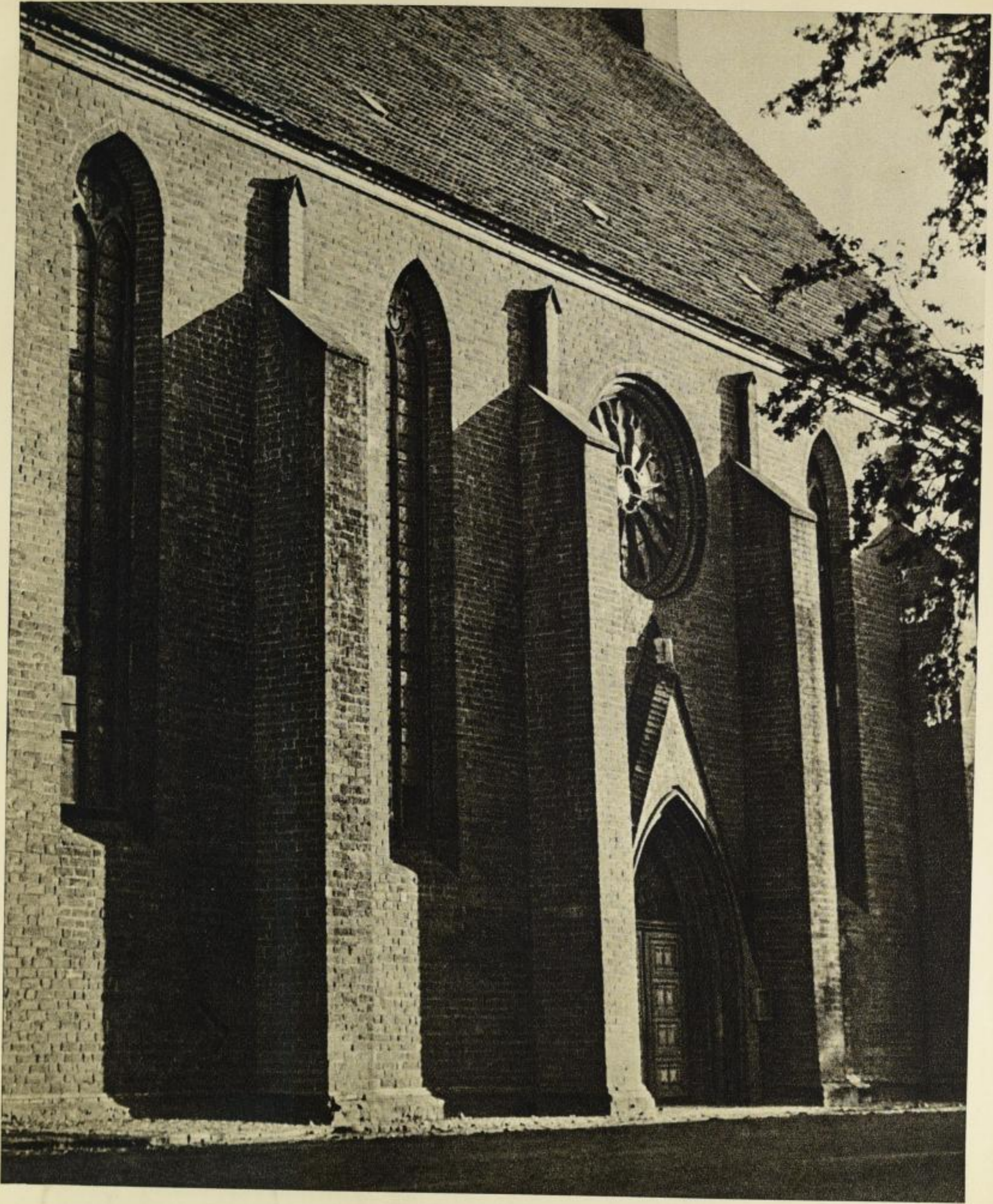
Neuruppin, Klosterkirche. Hohe, schmale Fenster und schlanke Strebe Pfeiler verstärken die Höhenwirkung des Gebäudes
