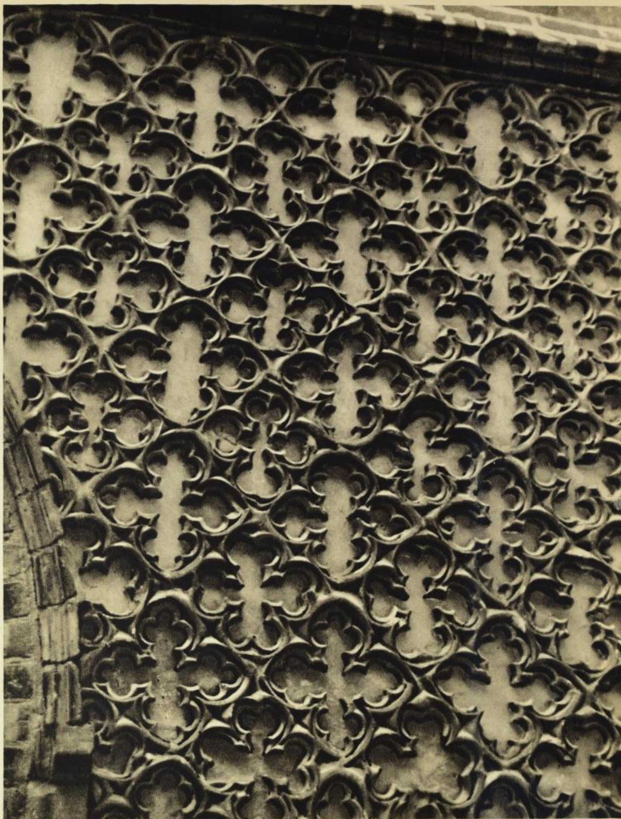
Formsteinschmuck an der Wand der reichgegliederten Nordkapelle der Katharinenkirche in Brandenburg
