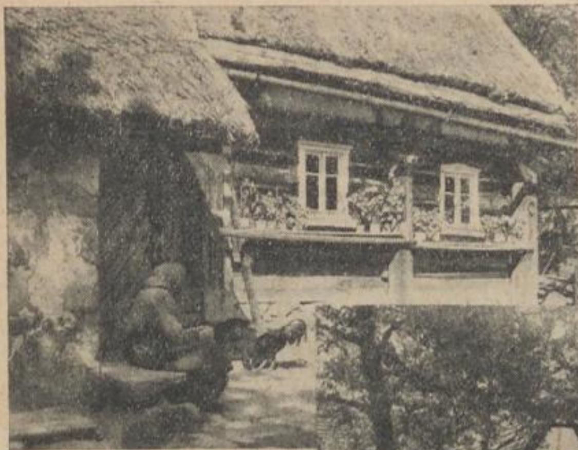
Umgebäudehaus in Lauba
