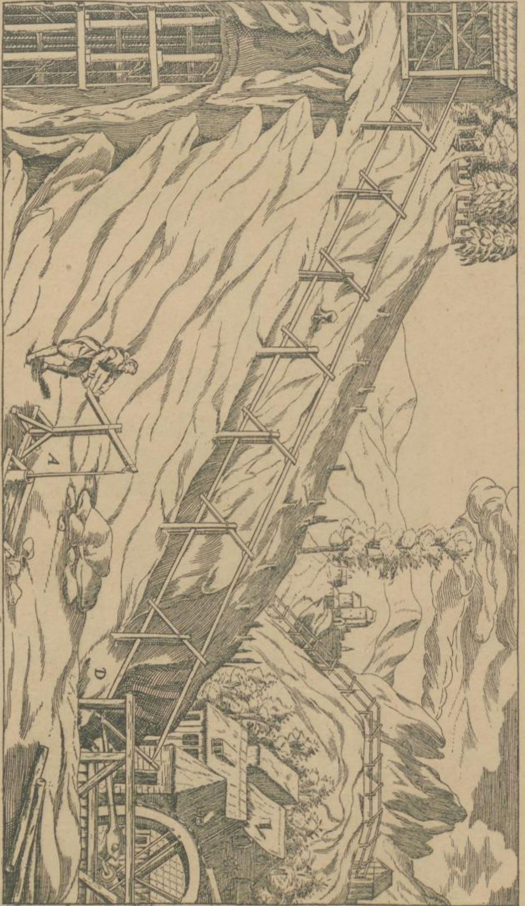
Abbildung 3. Wasserhaltung A mit Sandpumpe, D mit Wasserradantrieb und Gefänge für die Kraftübertragung.
