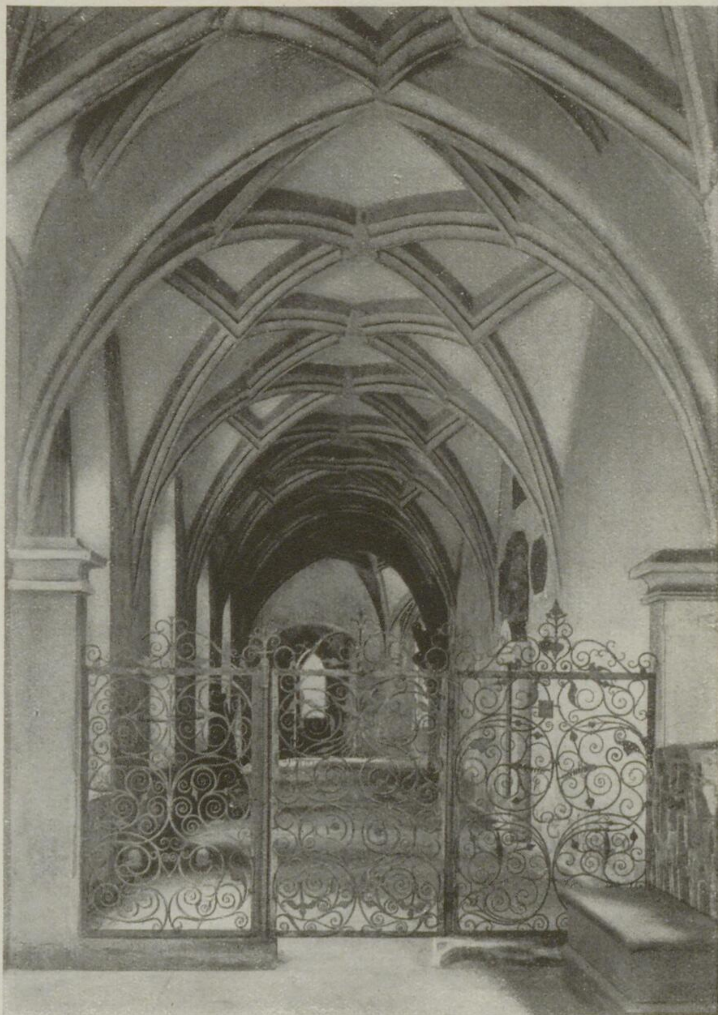
Kreuzgang am Ende des Südflügels mit dreiteiligem schmiedeeisernen Gitter und spätgotischem Netzgewölbe
