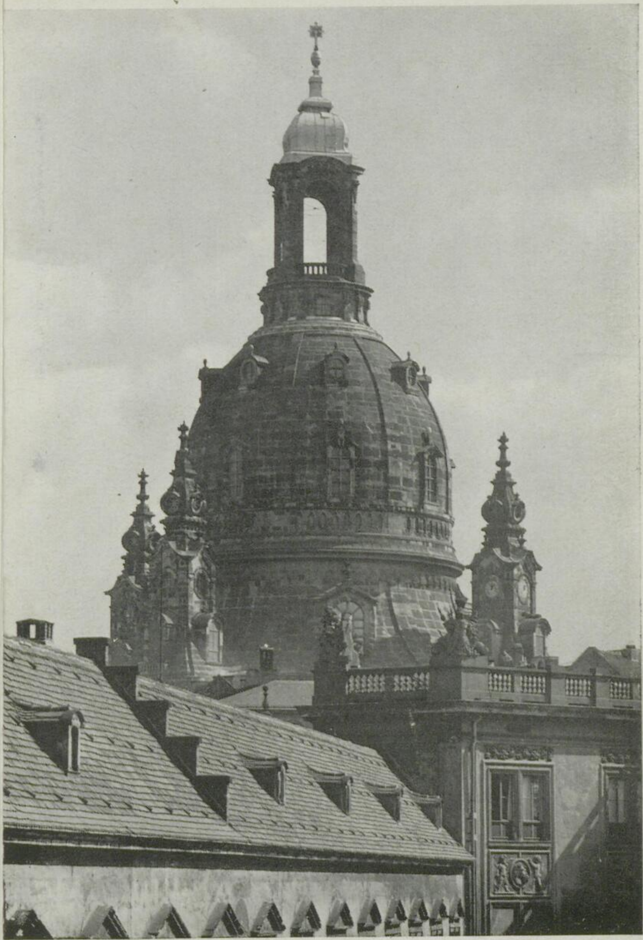
Die Kuppel mit dem Stallhof. Blick vom ehemaligen Residenzschloß
