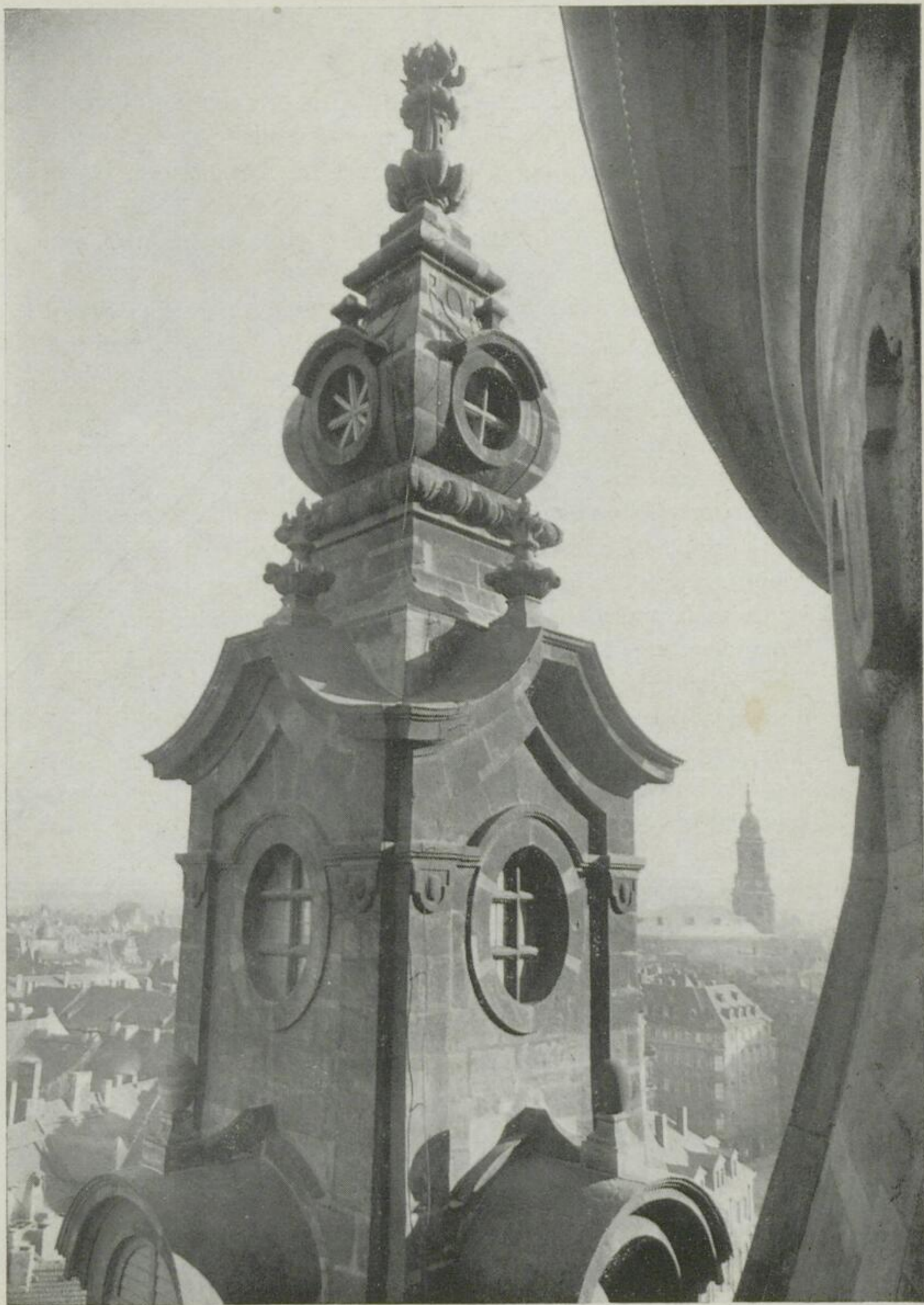
Einer der Treppentürme neben der Kuppel
