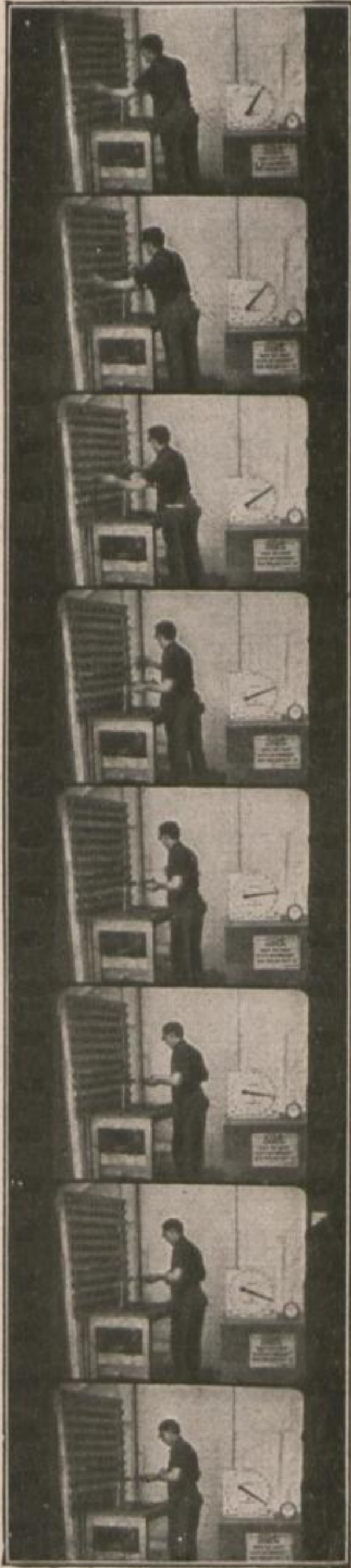
Abb. 4. Leistungsmessung; Montage einer Flechtmaschine.
