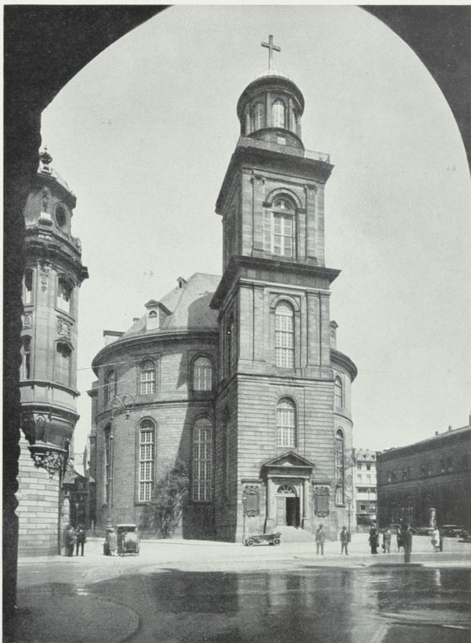
Abb. 200. Die Paulskirche, erbaut von 1783—1830 nach den Plänen der Stadtbaumeister Joh. Andreas Liebhardt und Joh. Friedrich Christian Heß des Jüngeren.
