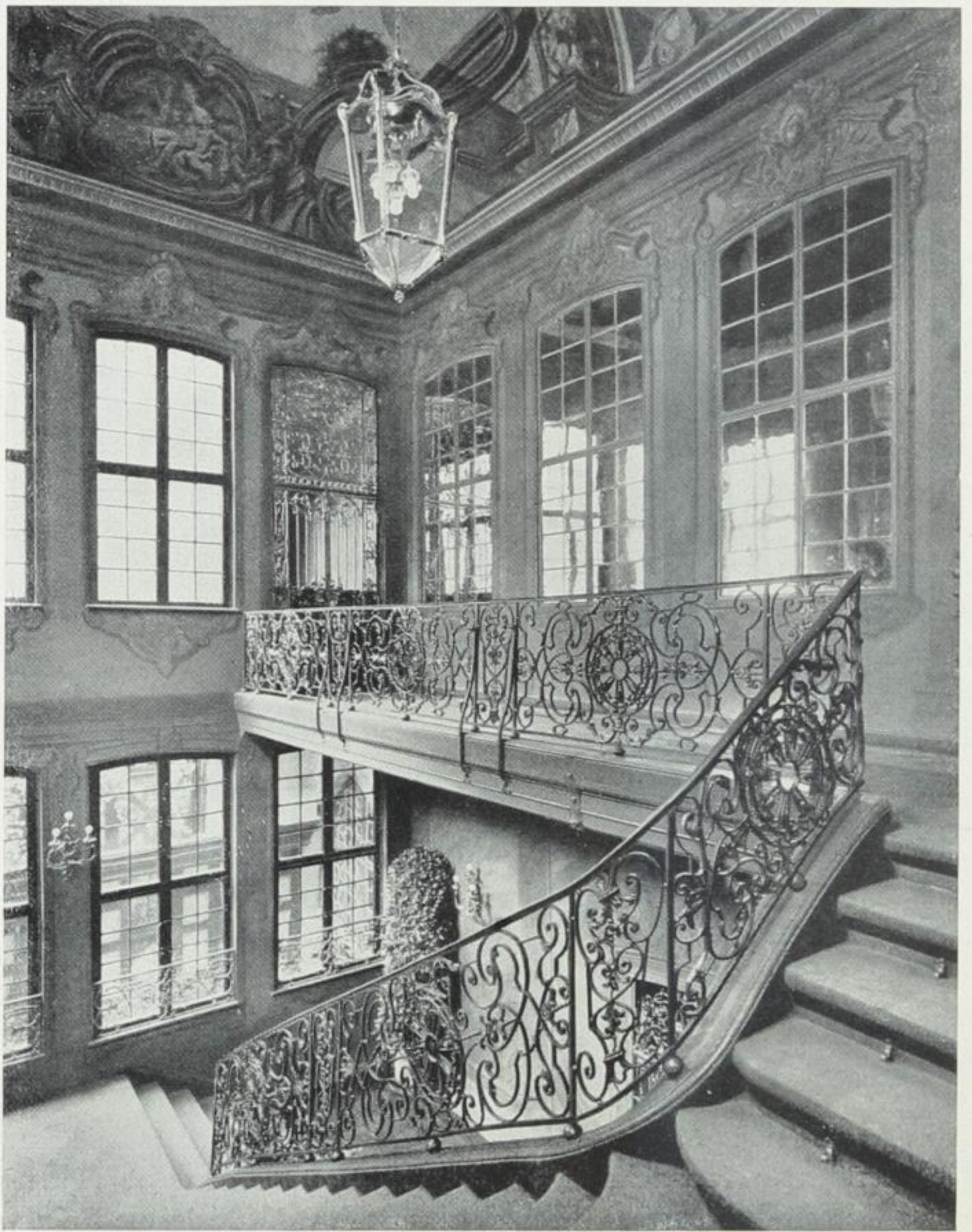
Abb. 172. Die Kaisertreppe im Römer, 1741 erbaut von Bergrat Pauli aus Kassel († 1756). Das Geländer fertigten die Frankfurter Schlossermeister Abt und Diestmann
