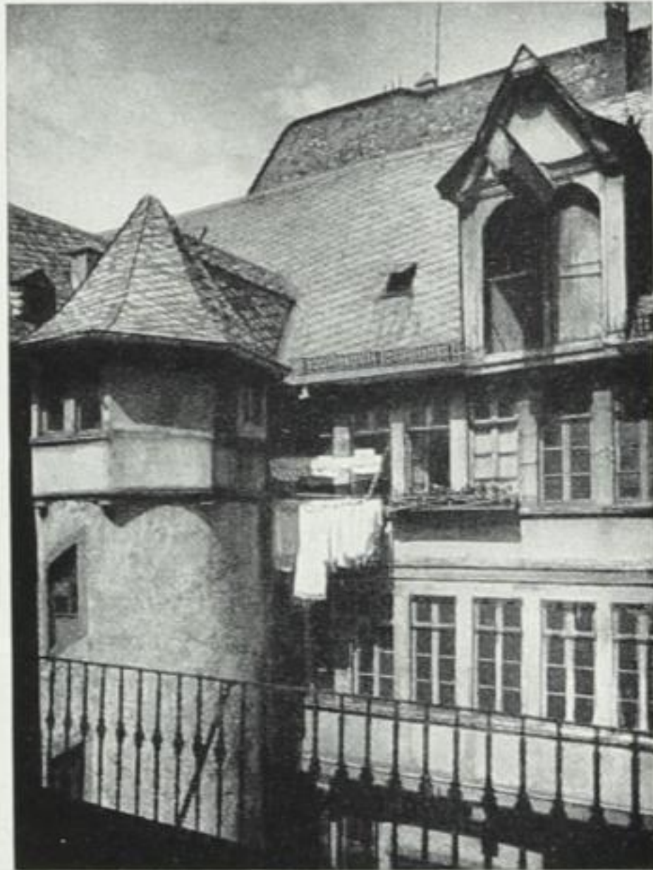
Abb. 57. Der kleine Sandhof, 15. Jahrhundert, 1589 erweitert, 1936 niedergelegt.
