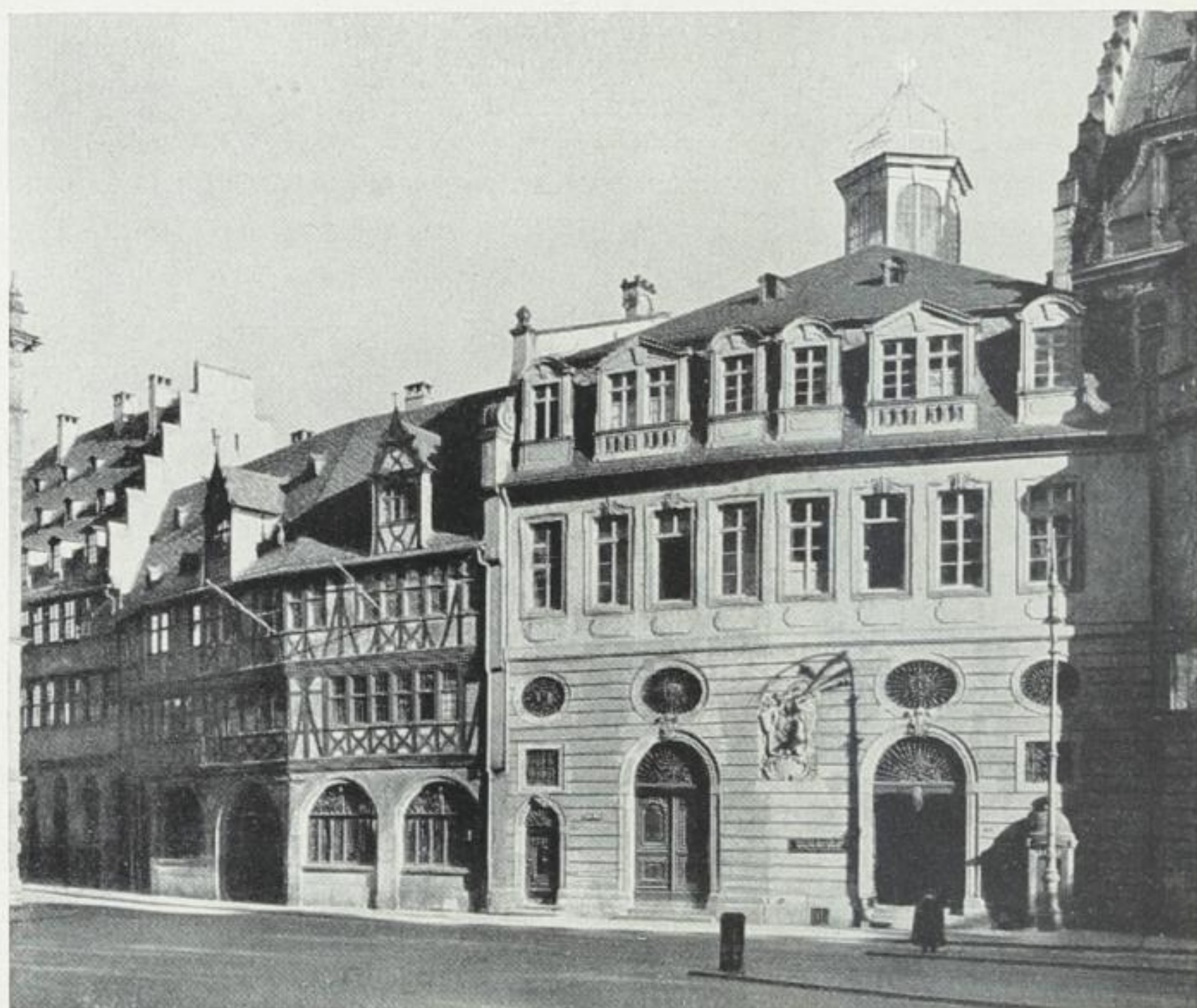
Abb. 163. Die Nordseite des alten Rathauses. Von rechts nach links die Häuser zum Goldenen Schwan, 1731 von Stadtbaumeister J. J. Samhaimer umgebaut, Wanebach und Salzhaus, beide um 1600.
