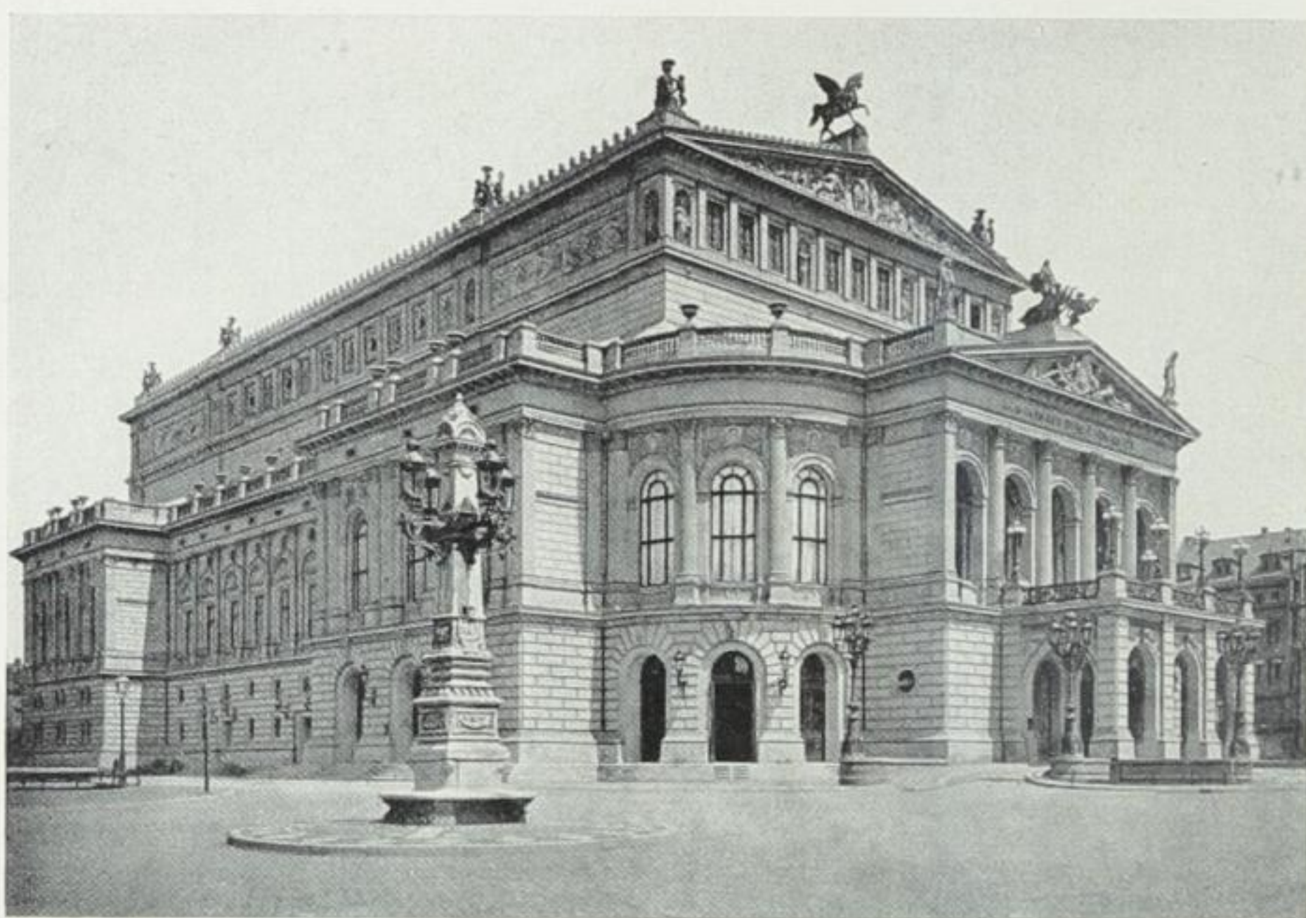
Abb. 244. Das Opernhaus. 1875–1880 erbaut nach den Plänen von Richard Lucae (1829–1877).
