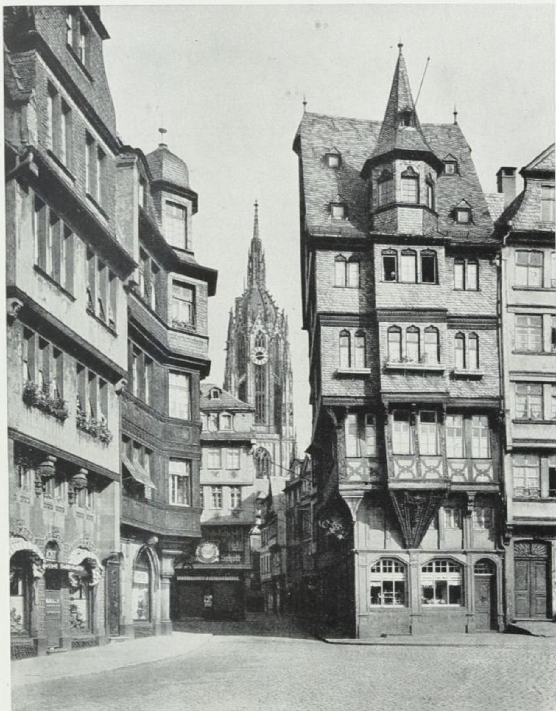
Abb. 22. Römerberg, alter Markt und Dom. Rechts das Haus zum Engel, erbaut 1562.
