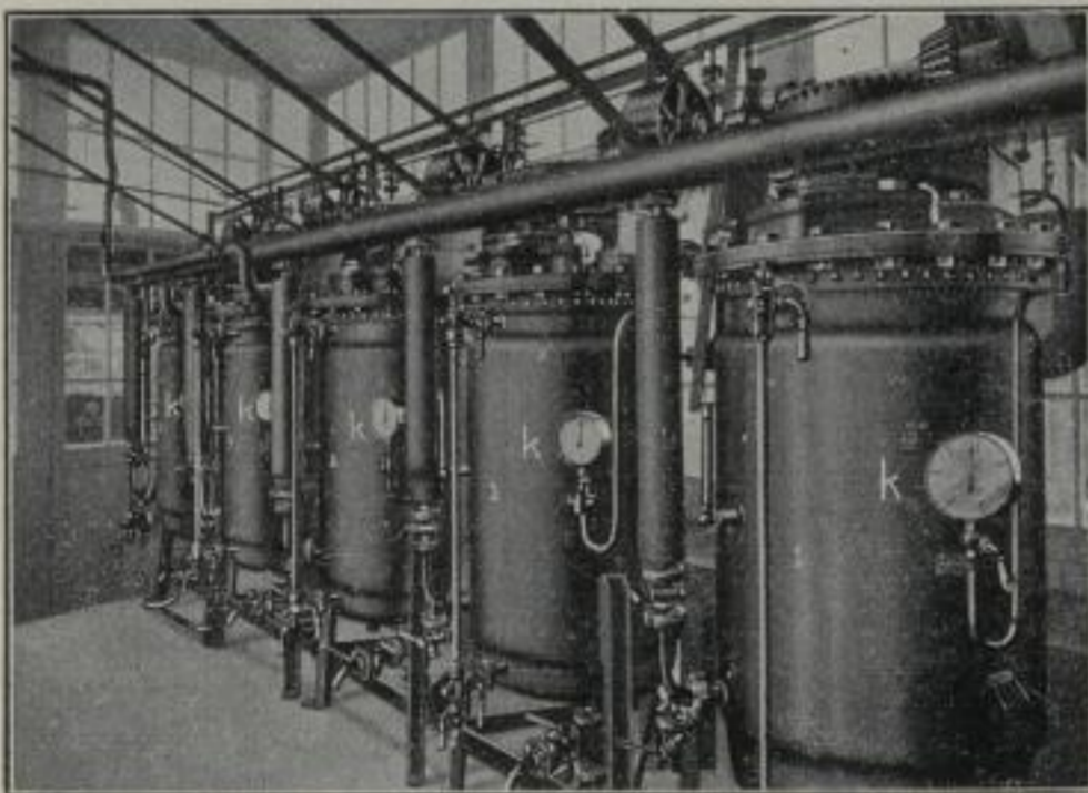
Abb. 2. Der Filtrier- und Reifungsraum. (Oscar Kohorn & Co., Chemnitz-Wien)
