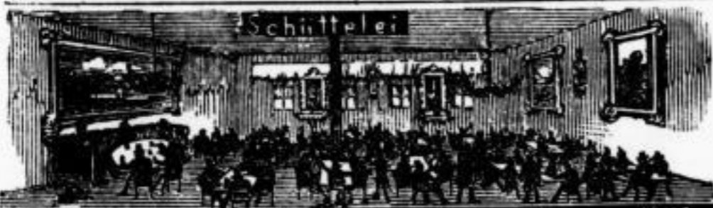
Restauration von Rob. Schüttel, Gerichtsweg N. 1.
