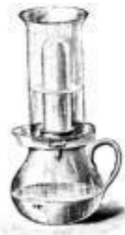
Zeiss-Filter (1/2 mit 900) liefert im Tage reichlich das von einer Familie benötigte Trinkwasser.
