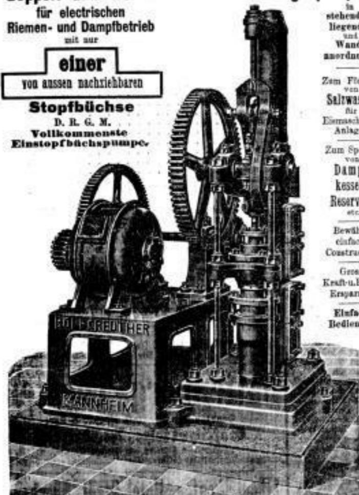
Doppeltwirkende Speise-Pumpe mit elektrischem Antrieb.
