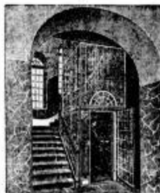
Personen-Aufzug in Treppenhause.
