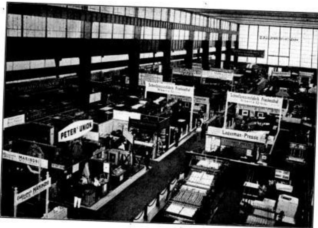
Das Innere der Maschinenhalle II.
