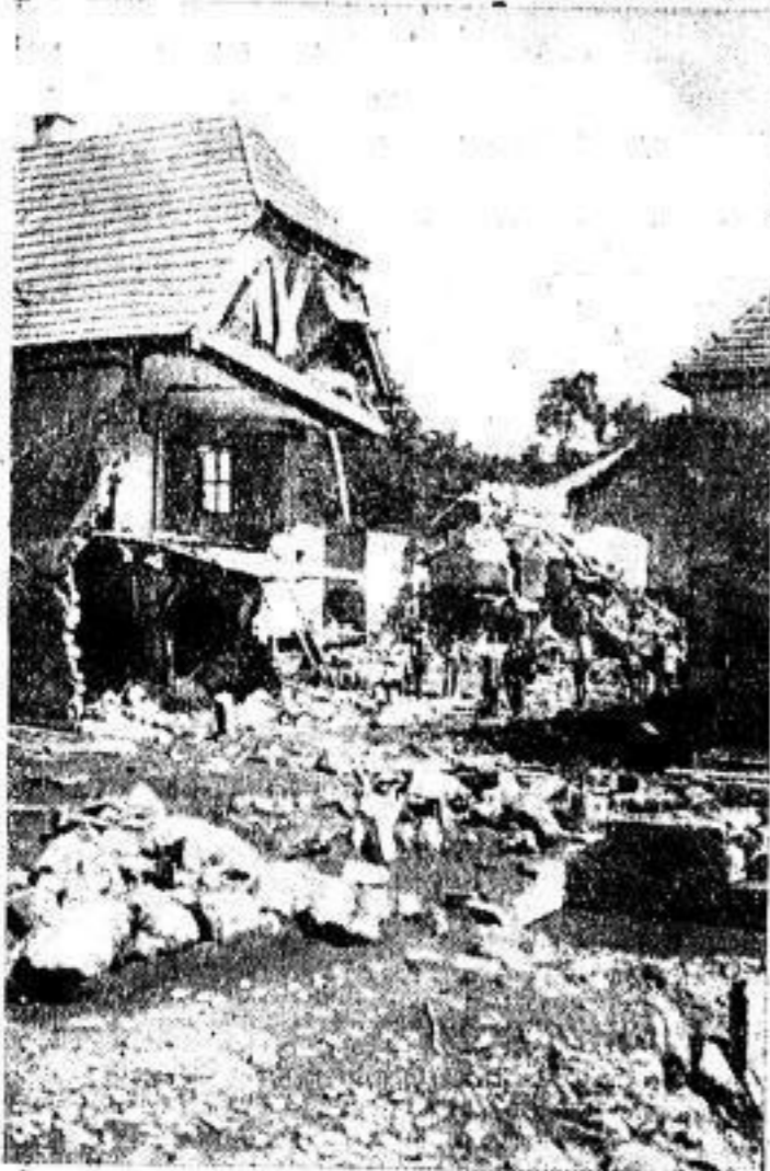
Zerstörtes Wohnhaus in Glashütte.
