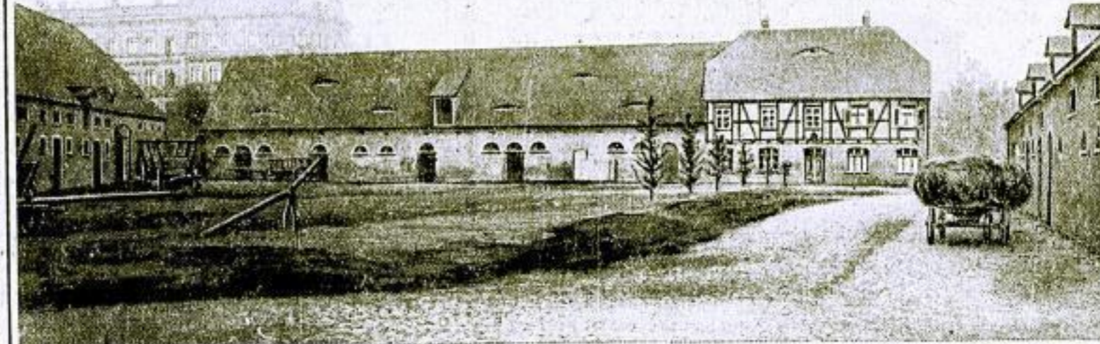
Der alte Fettviehhof, dessen Entwurf Ernst Pinterl bewerkstelligte. Blick nach der Waffendorfer Straße; rechts im Hintergrunde der Eingang, dahinter das Albertgymnasium
