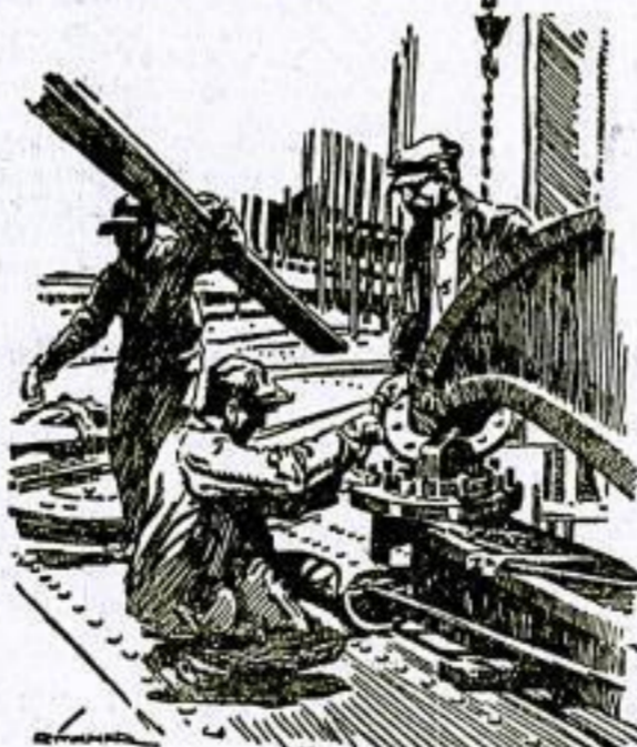
Der Presszylinder der Nietgänge wird geprüft.
