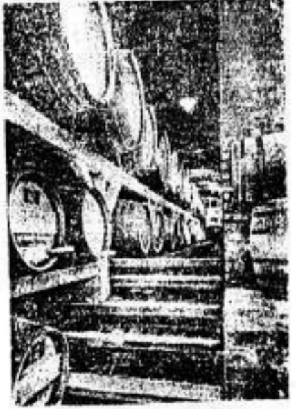
Teillansicht der Kellerei
