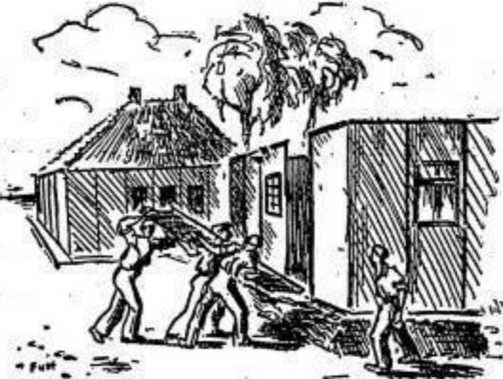
Abb. 2. Stahlhaus im Bau
