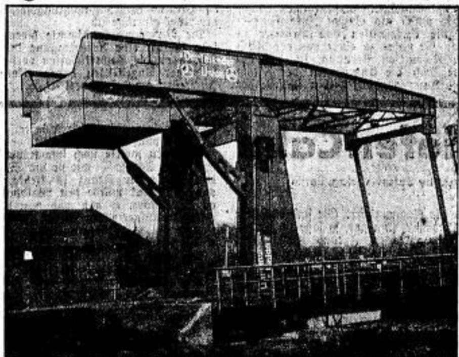
Die neue Klapp-Brücke in geschlossenem Zustand. Links sieht man das Gegengewicht, durch dessen Niederziehen die Oeffnung ermöglicht wird. In Swinemünde wurde eine neuartige Eisenbahnbrücke dem Verkehr übergeben. Es handelt sich um eine Klapp-Brücke, die mittels einer sinnreichen Gegengewichtskonstruktion geöffnet wird, und die dann der Schifffahrt einen ungehinderten Verkehr ermöglicht.
