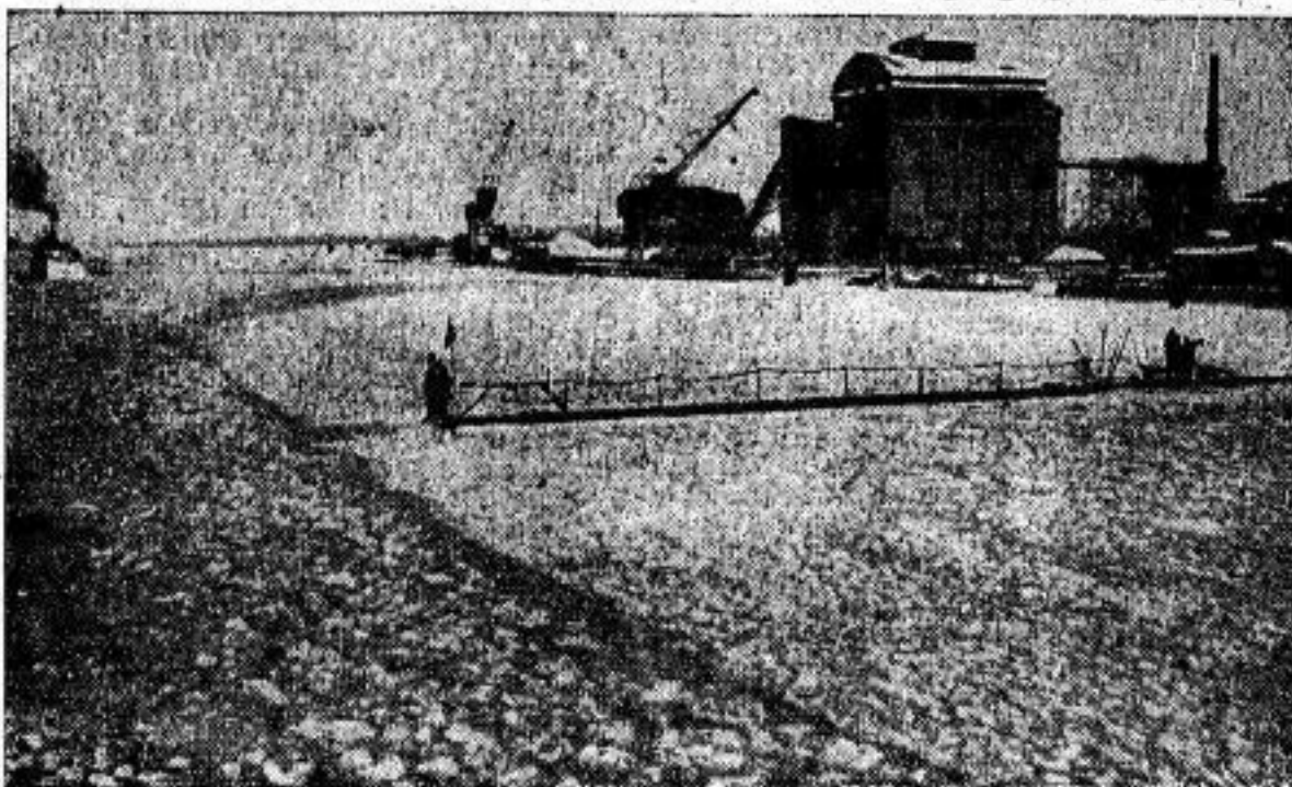
Die Notbrücke über die Oder unterhalb Steffins
