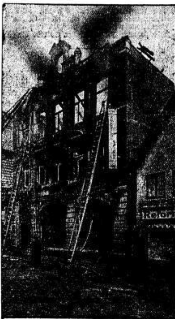
Bild vom Detmolder Hofelbrand Die Brandruine des Hotels „Zur Traube“ in Detmold
