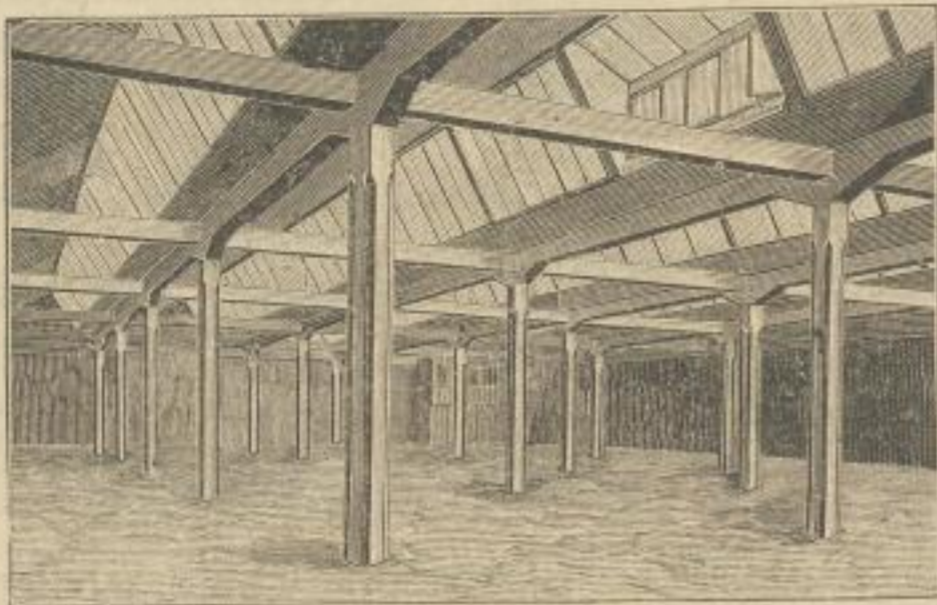
Isolierender Eisenbetonschiff — Mech. Buntweberei Brennet.
