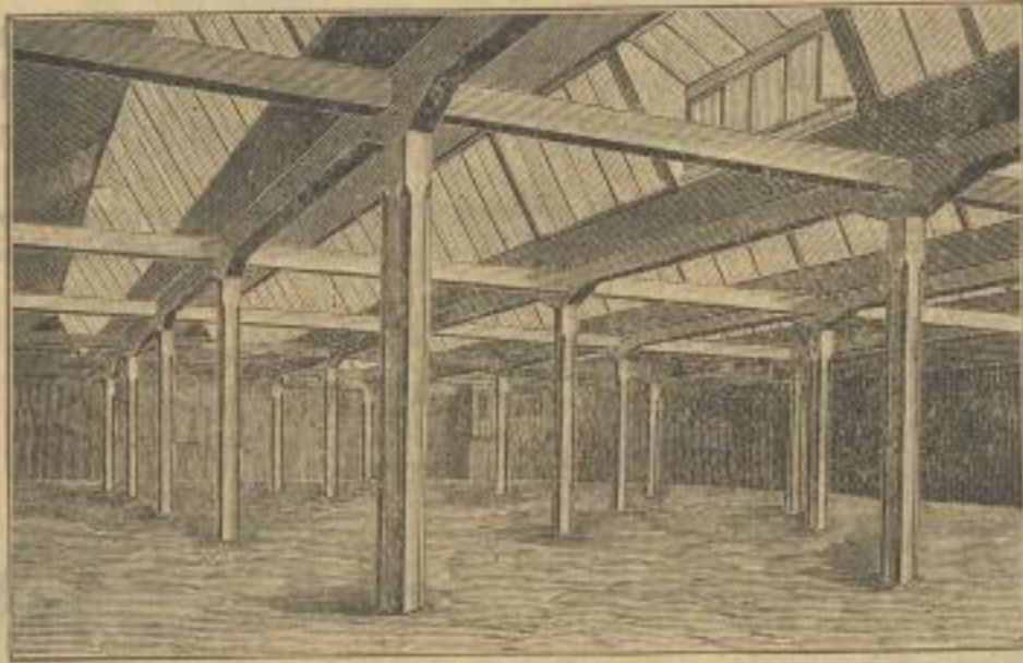
Isolierender Eisenbetonsbed — Mech. Buntweberei Brennet.
