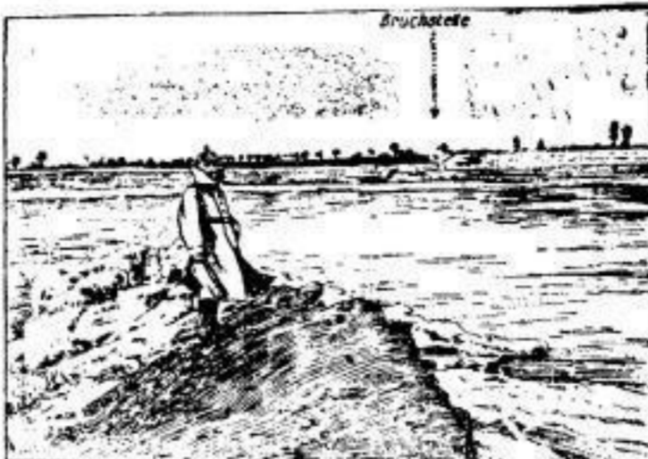
Die Bruchstelle des Eisdamms bei Berge
