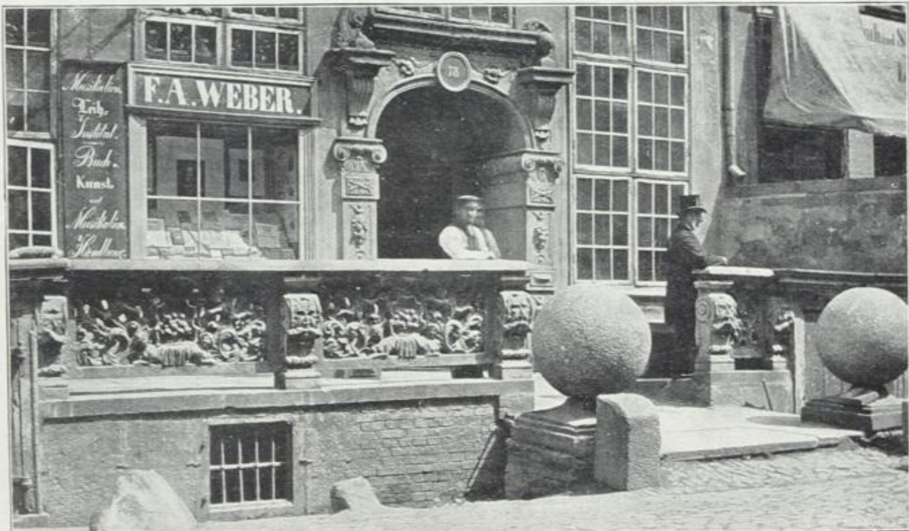
Abb. 88. Beischlag aus der Langgasse (abgebrochen)
