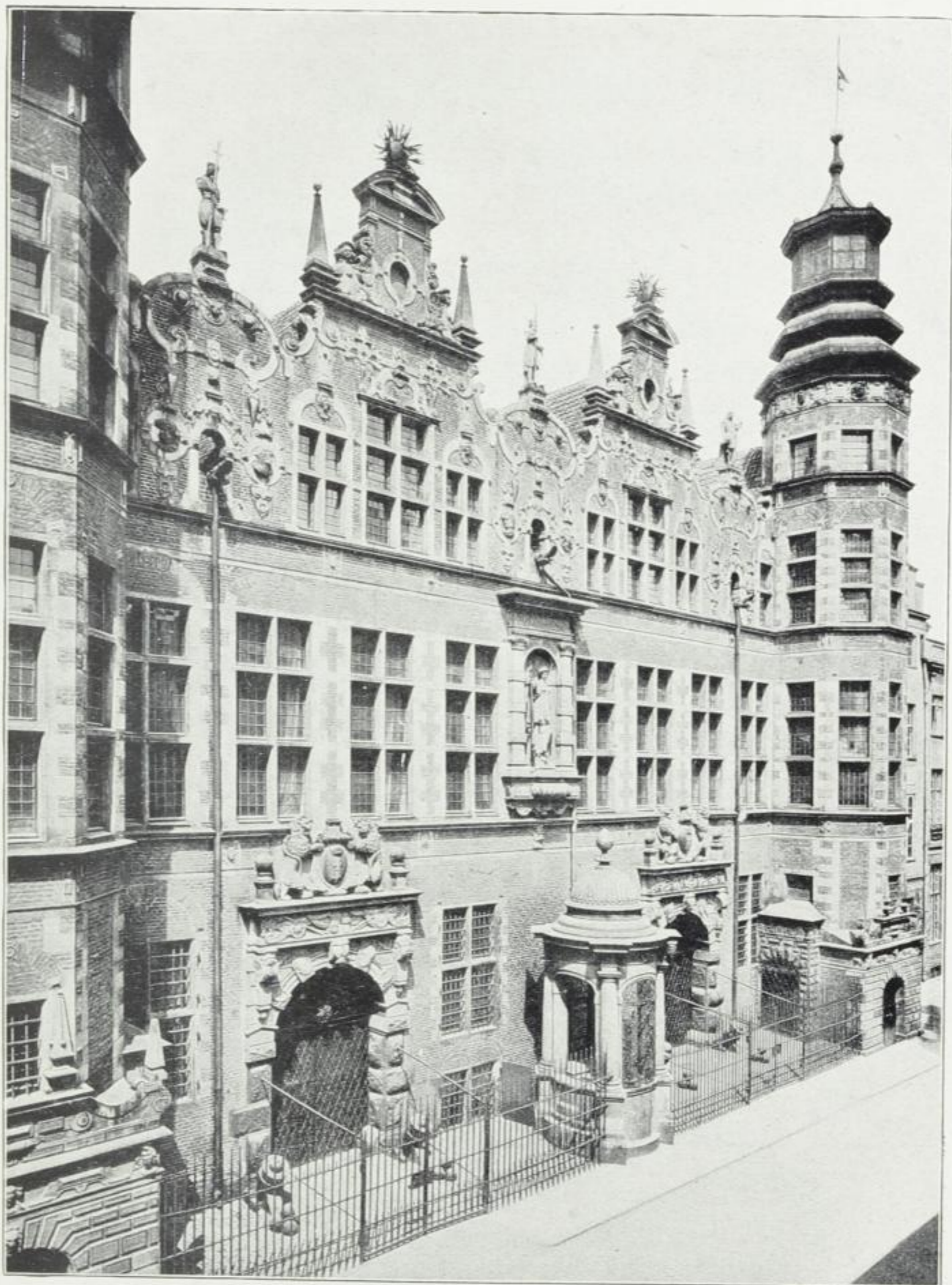
Abb. 69. Zeughaus: Fassade nach der Zopengasse. (Phot. Kuhn)
