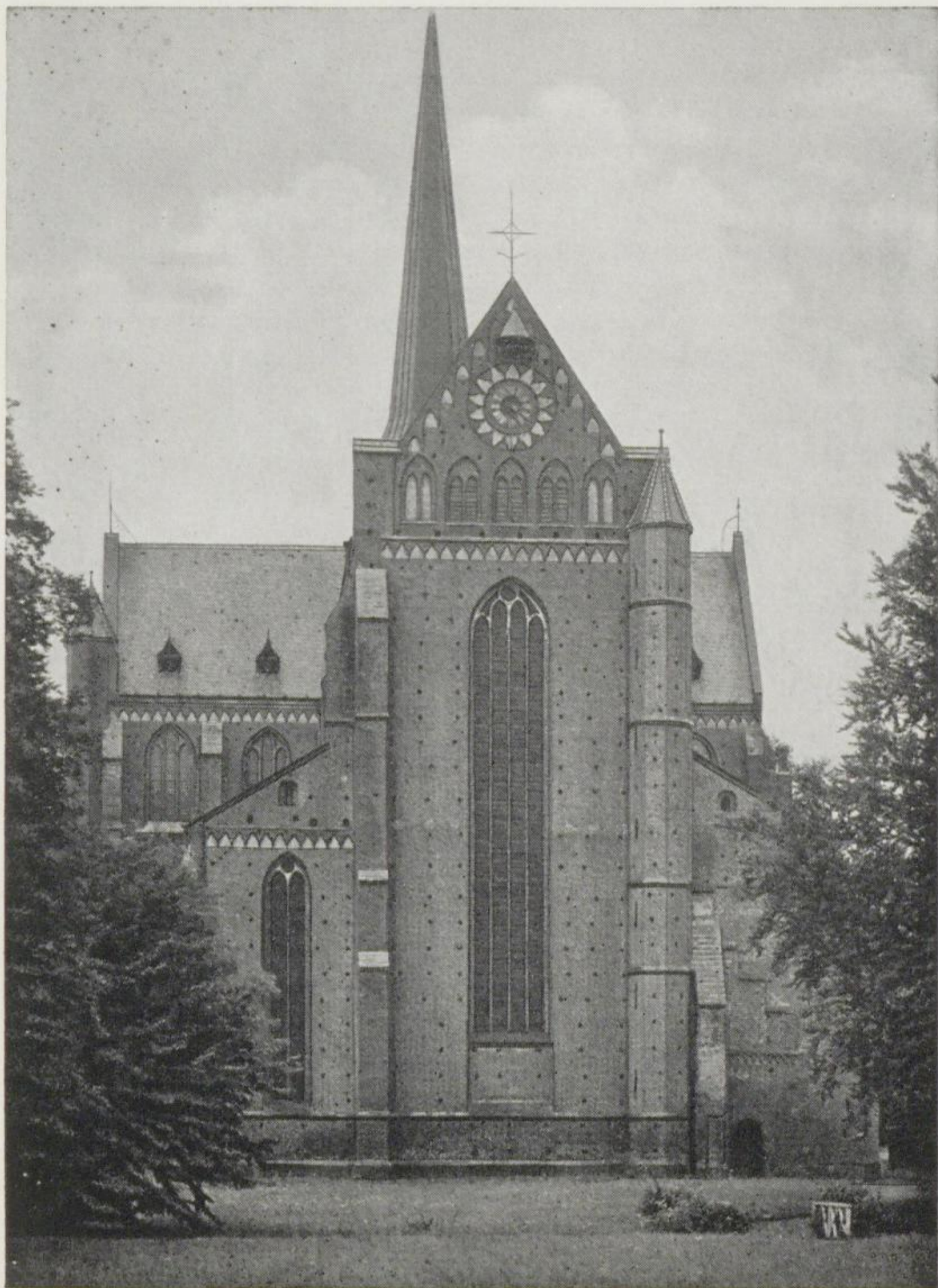
Ansicht von Westen
