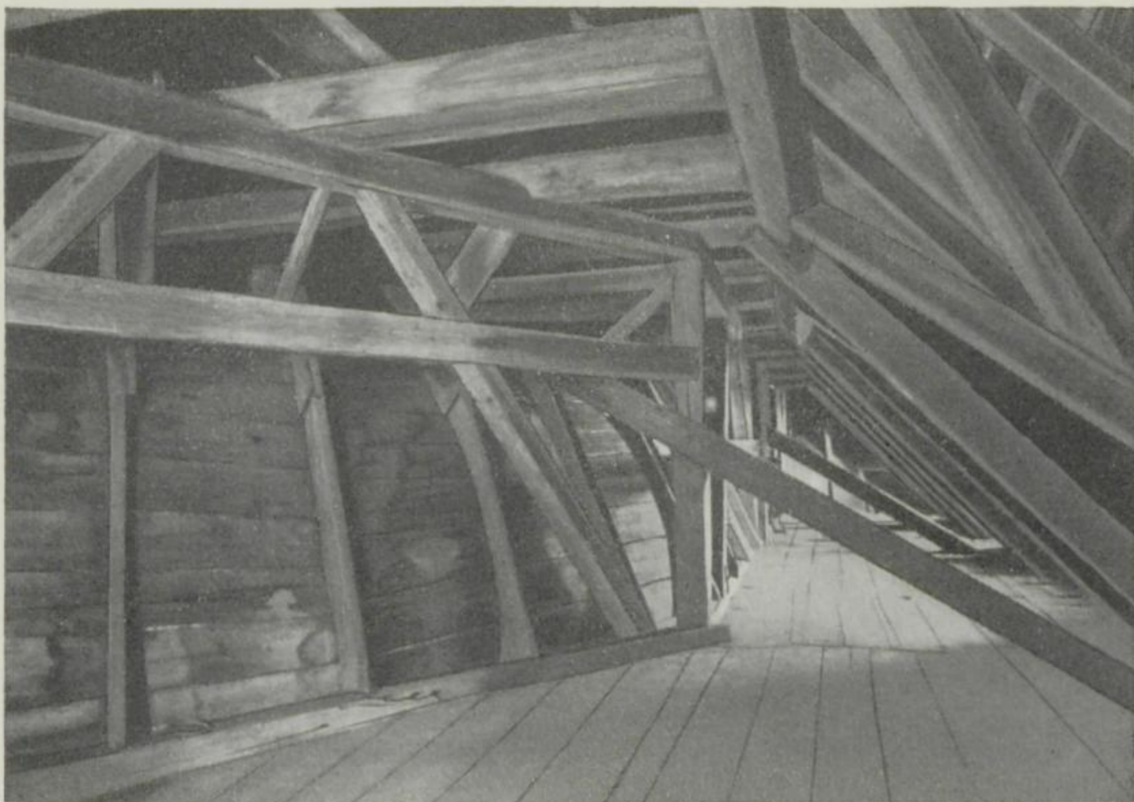
Dachkonstruktion und Holzverschalung der stukkieren Tonnenwölbung
