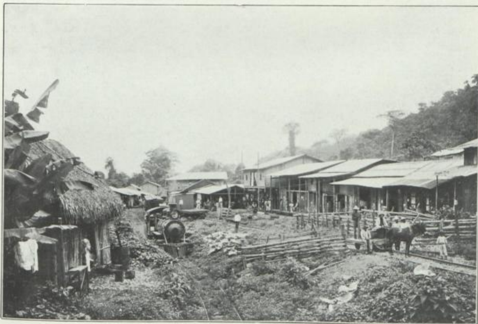
Abb. 10. Station Chimbo der Guayaquil-Quito-Eisenbahn. Photographie von J. Horgan jr., Scranton U. S. A.
