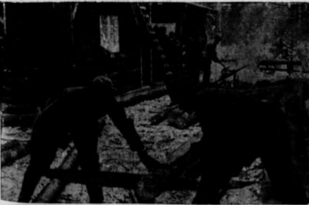
Links: Wetterfeste Blockhäuser entstehen an der Ostfront. Die Wände bestehen aus Baumstämmen, die Zwischenräume werden mit Moos ausgefüllt. (D.R.-Kopf, Kriegsb., Katoski, III.)
