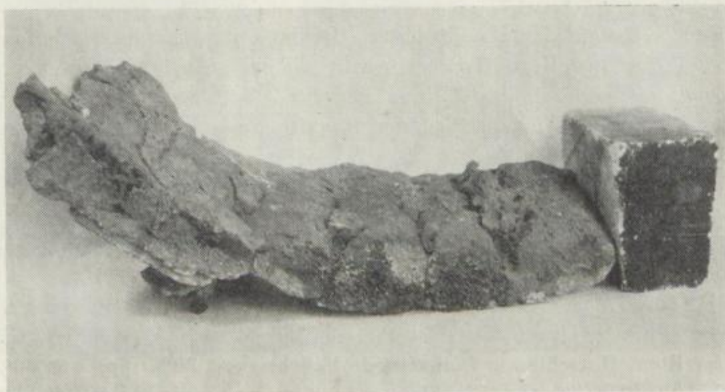
Bild 6. Segment der verschlissenen Wandung; daneben ein intakter Stein
