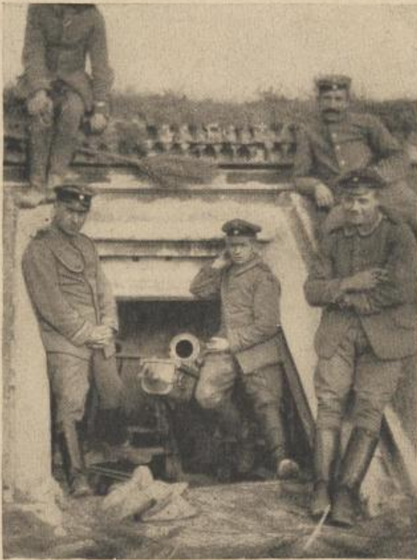
Abb. 4. Ein betonierter Geschützstand der 5. Battr. an der Mische Links unten: Vizewachtmstr. d. L. Boeck Rechts unten: Offz. d. Res. Findeisen
