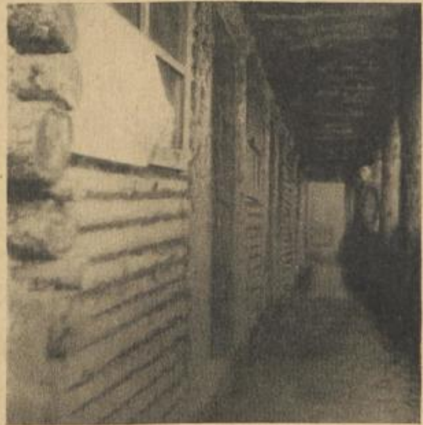
Abb. 18. Unterstand der 1. Batterie
