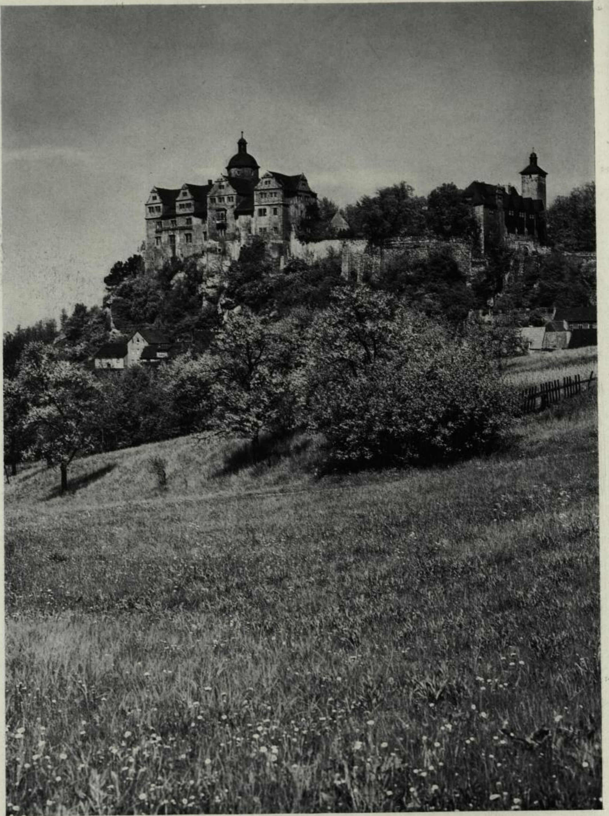
76. Burg Ranis. Hauptburg mit Torbefestigung
