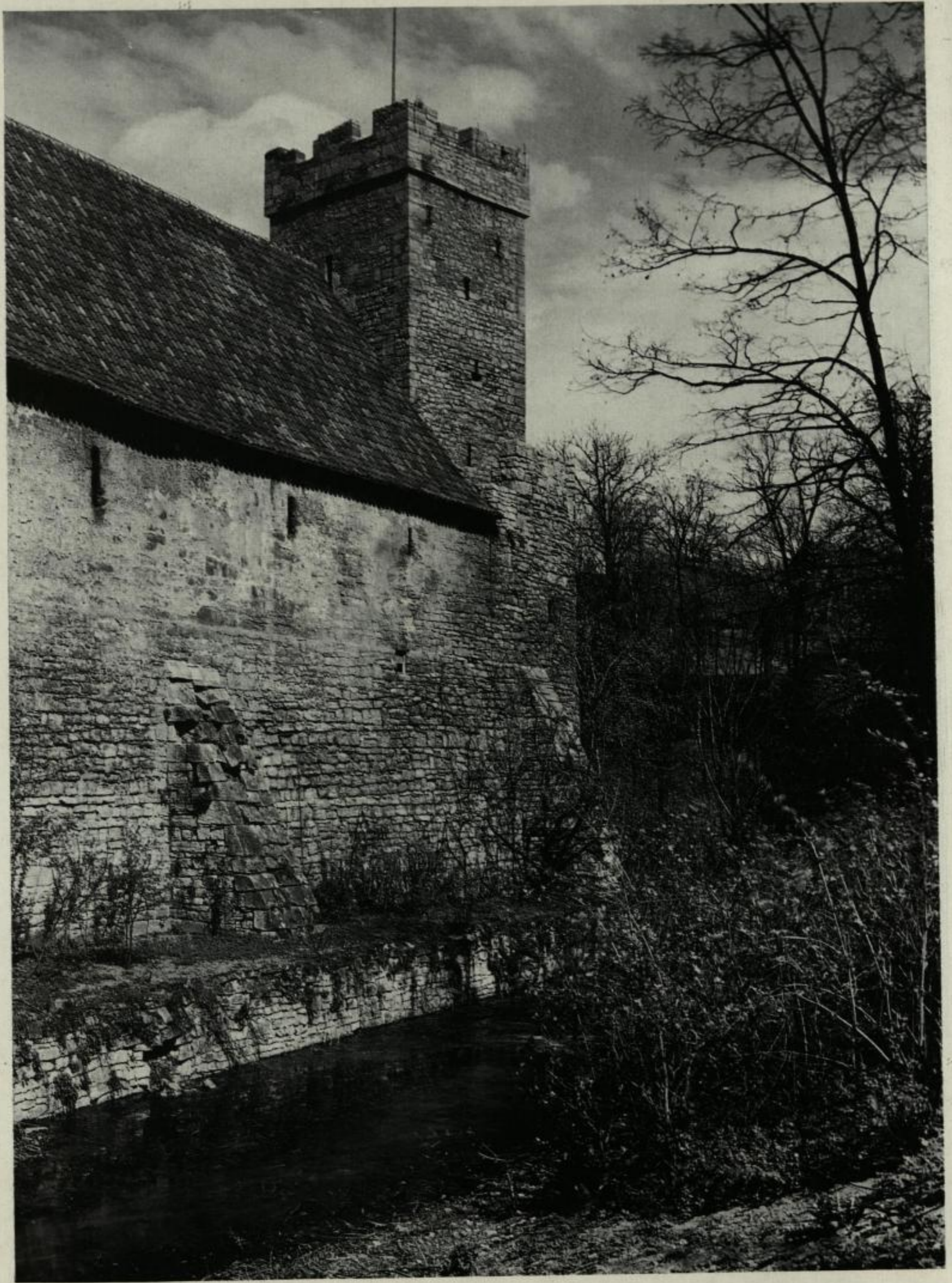
86. Wasserburg Kapellendorf. Ringmauer mit Eckturm
