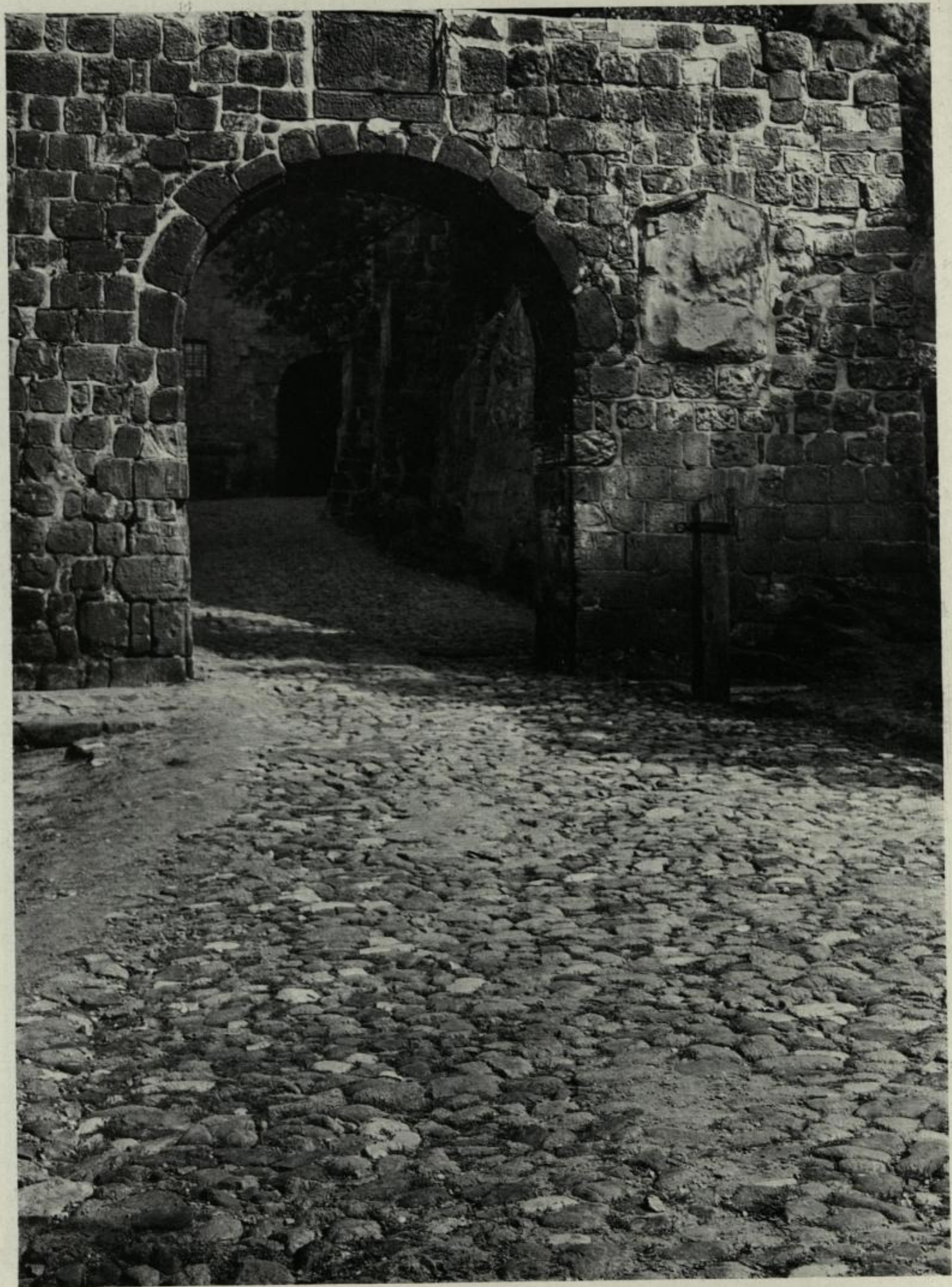
48. Stiftsburg Quedlinburg. Äußeres Burgtor
