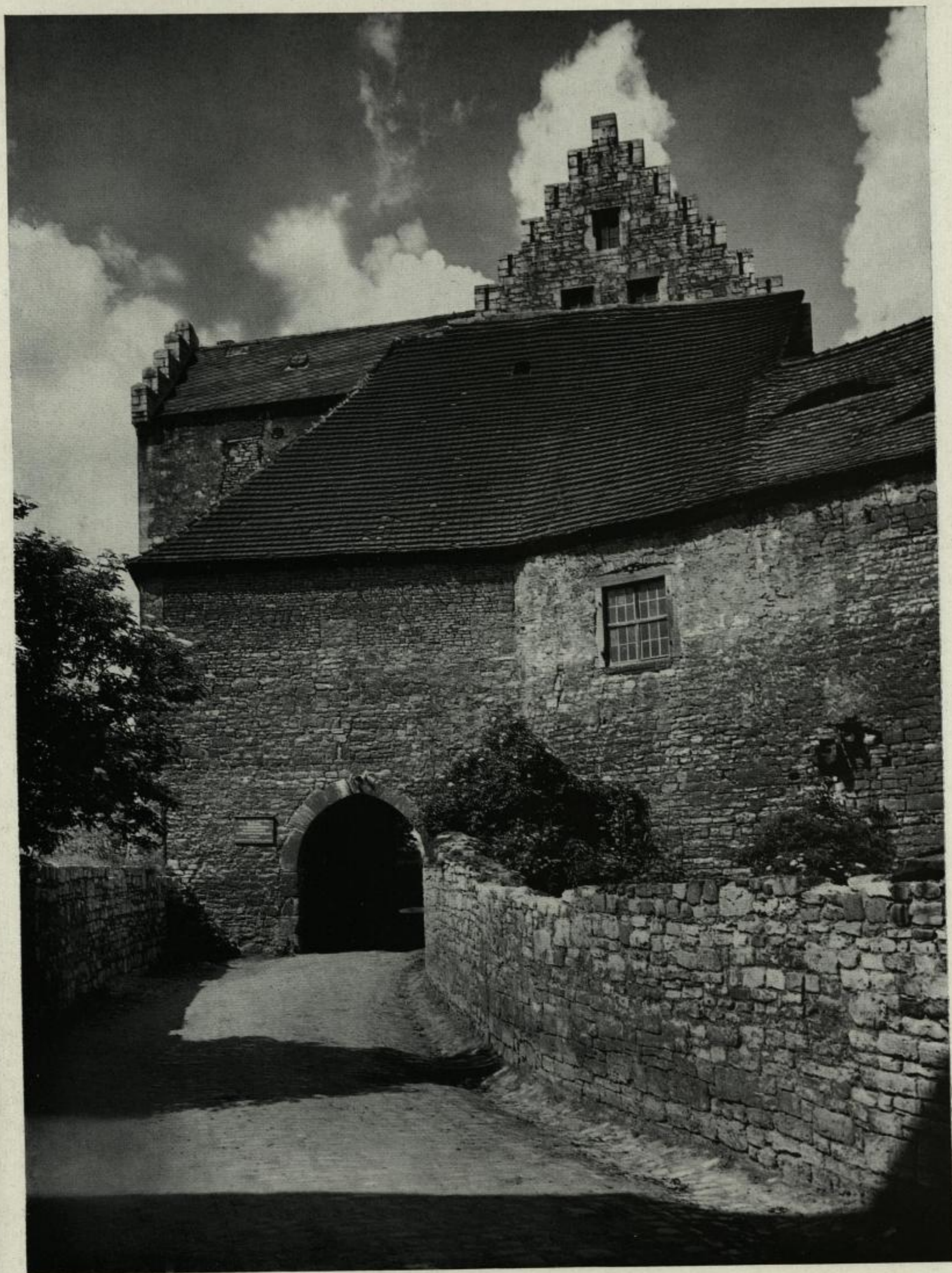
23. Neuenburg. Der ursprüngliche Burgzugang
