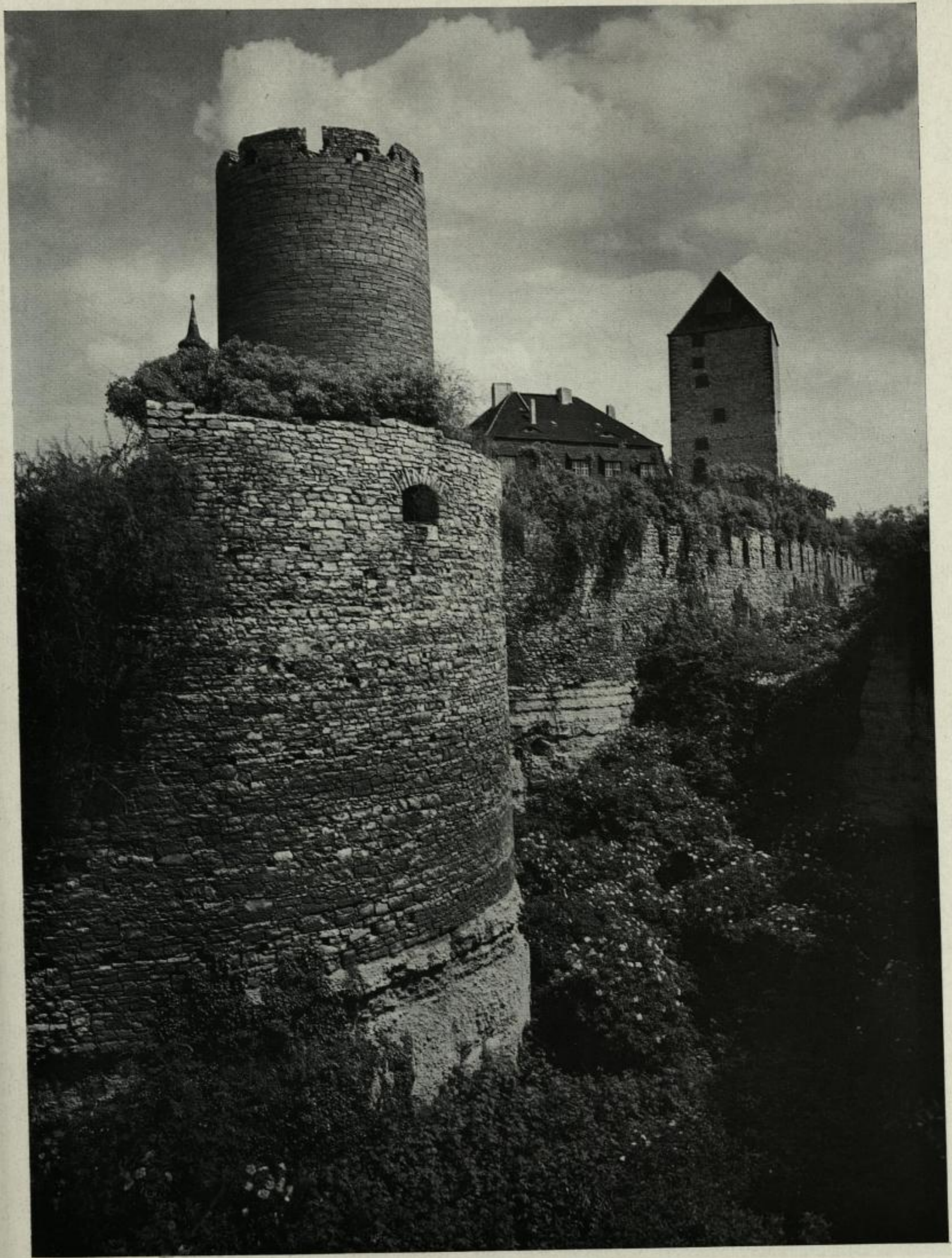
7. Burg Querfurt. Westliche Ringmauer mit Burggraben
