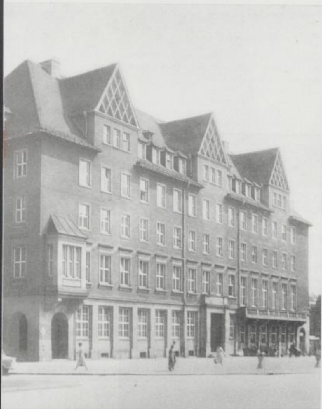
Neues Sorbenhaus in Bautzen
