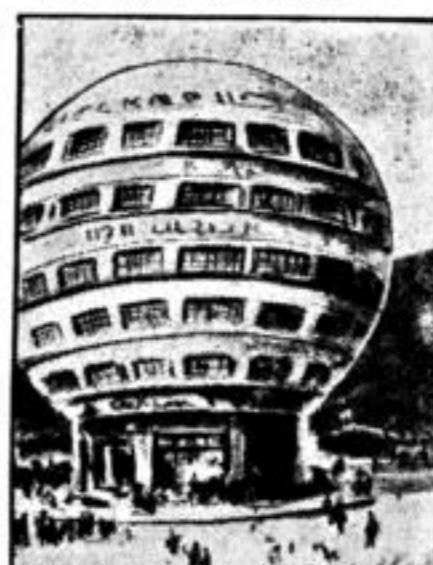
Auf der diesjährigen Ausstellung der Jahreschau Deutscher Arbeit, Dresden, "Die Technische Stadt", wird, nach dem Entwurf des Münchener Architekten Professor Wirkensholz, ein Kugelhaus mit einem Durchmesser von 25 Metern auf einem Sockel von 5 Meter, also mit einer Gesamthöhe von 30 Metern, errichtet. Der Vorbau des Kugelhauses liegt in der Weitläufigkeit.
