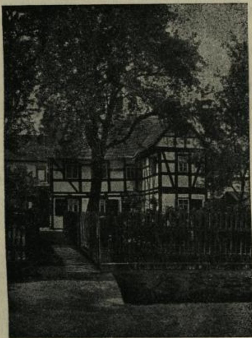
Häuschen mit vollständigem Fachwerk (Nr. 38 an der Staatsstraße, Bes. Emil Augustin).
