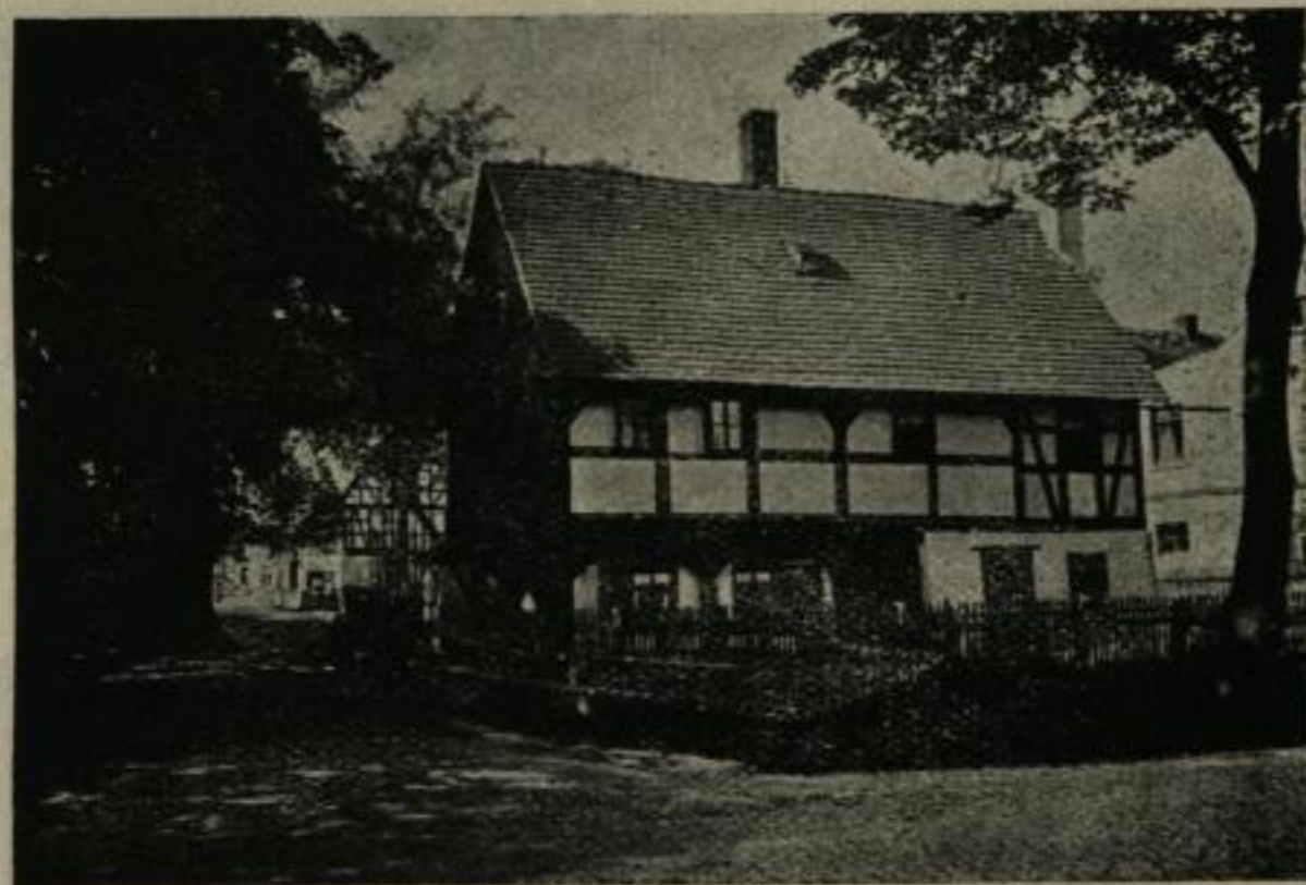
Haus mit hölzernen Stützsäulen No. 4 (Frankenthal), Bes. Frau Wwe. Kommerzienrat Strauß.
