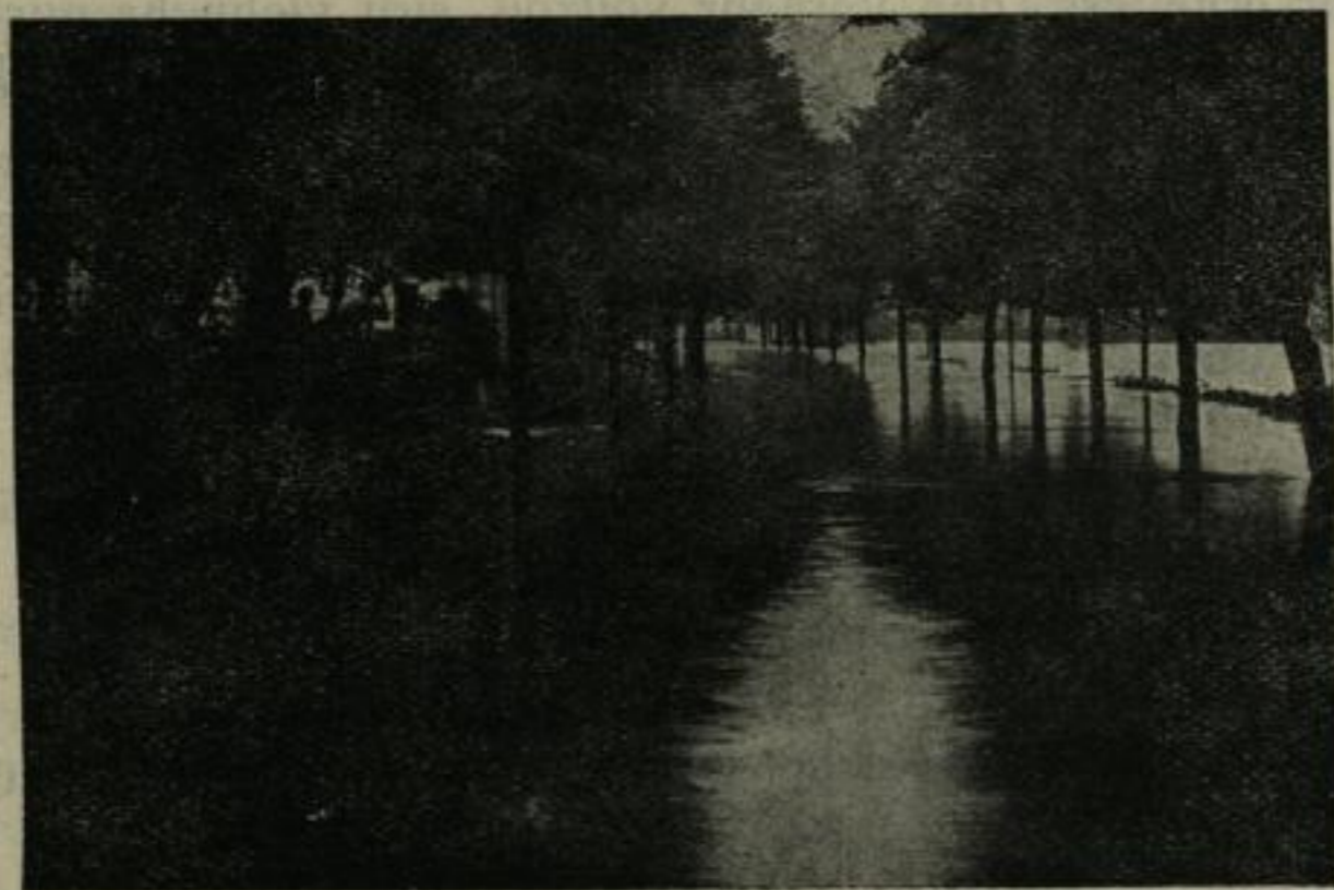
Hochwasser am 31. Juli 1897 (bei Haus Nr. 39).
