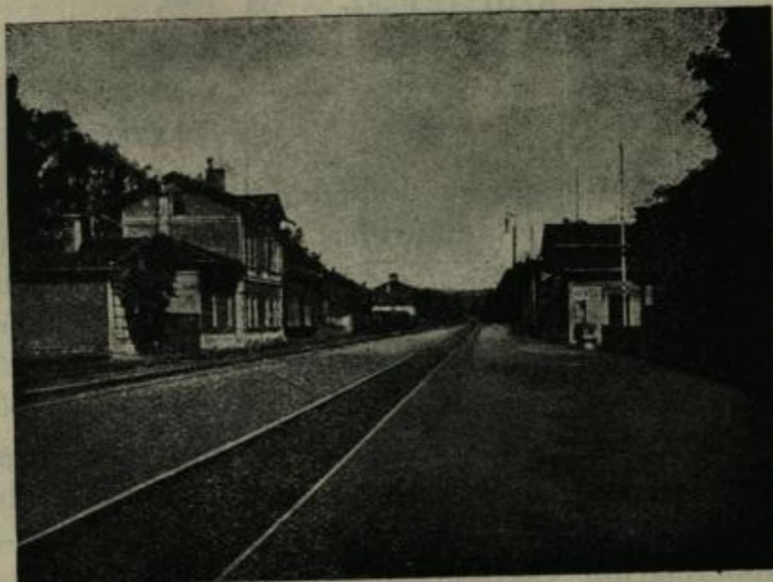
Der Bahnhof Remse, im Hintergrund links: Trocknungsanlage.
